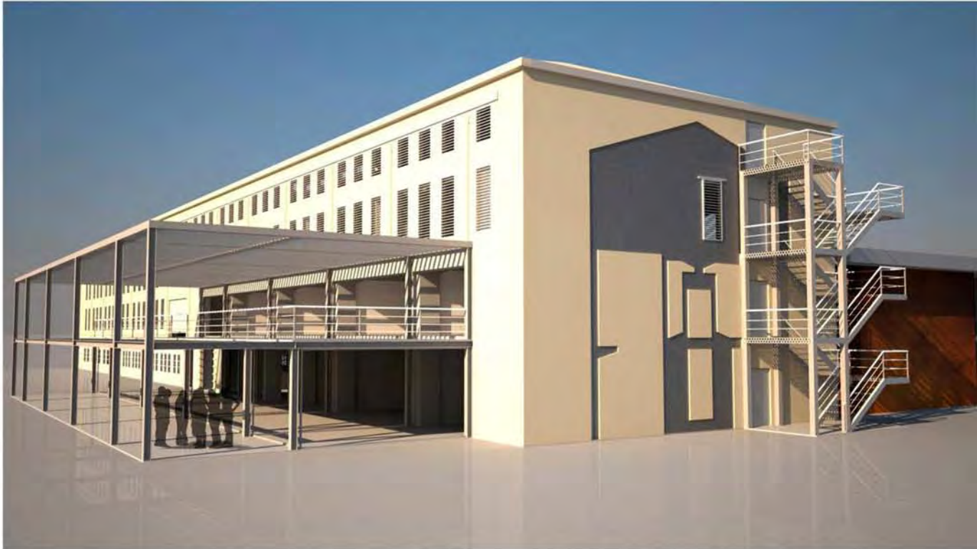
Το κεντρικό κτίριο με το εξωτερικό κλιμακοστάσιο και η μεταλλική κατασκευή
