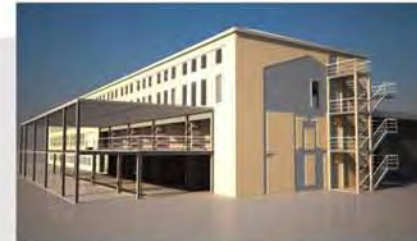
Μεταλλική κατασκευή & εξωτερικό κλιμακοστάσιο
