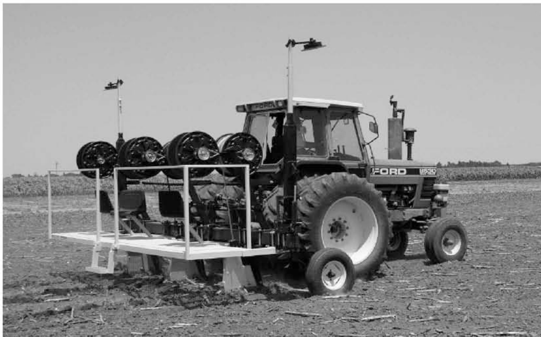
Φωτογραφία 5.1: Τοποθέτηση υπόγειου δικτύου άρδευσης με υπεδαφοθέτη προσαρμοσμένο σε τρακτέρ. Φωτογραφία F. R. Lamm - Kansas State University.
