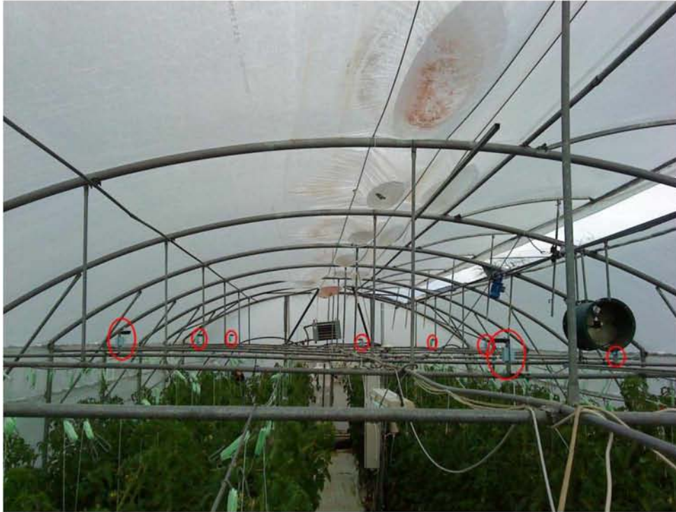
Εικόνα 3.7. Τοποθετημένοι οι πρώτοι δέκα αισθητήρες μέτρησης πάνω από την καλλιέργεια.
