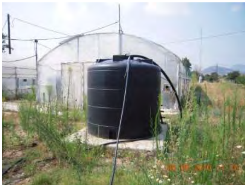
Δεξαμενή συλλογής του νερού της γεώτρησης του αγροκτήματος
