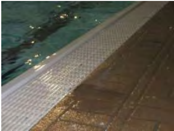
Εικόνα 6.6: Αύλακες υπερχειλίσης στο δάπεδο
