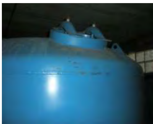
Εικόνα 6.1: Θυρίδα ελέγχου αμμόφιλτρου
