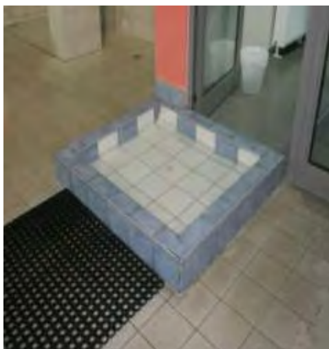
Εικόνα 6.11: Ποδολουτήρας
