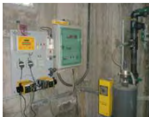
Εικόνα 6.3: Έλεγχος pH - Αυτόματη ρύθμιση
