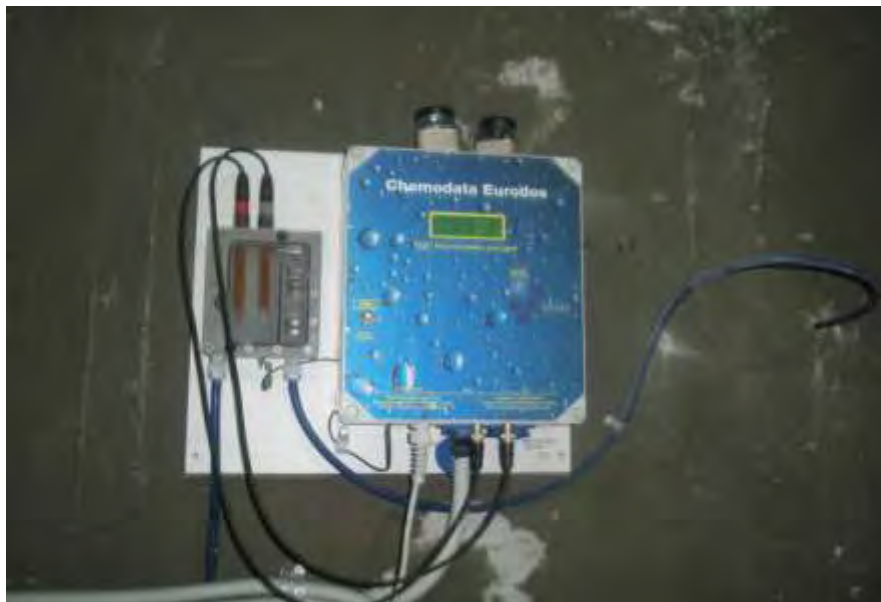
Εικόνα 6.18: Πίνακας ελέγχου υπολειμματικού απολυμαντικού
