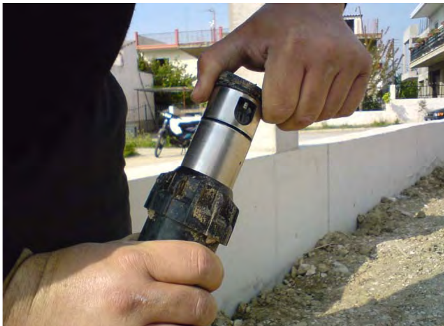
Εικόνα 8.2 pop-up εκτοξευτήρας στον εξωτερικό χώρο του Ξενώνα του Δήμου Νέας Ιωνίας Μαγνησίας
