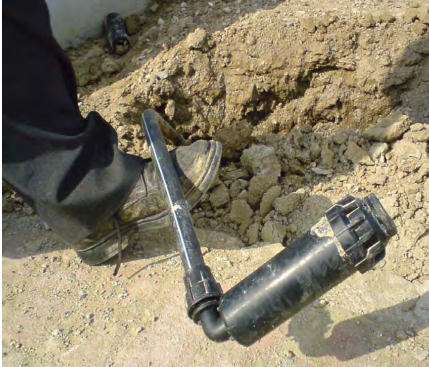
Εικόνα 8.1 pop-up εκτοξευτήρας στον εξωτερικό χώρο του Ξενώνα του Δήμου Νέας Ιωνίας Μαγνησίας
