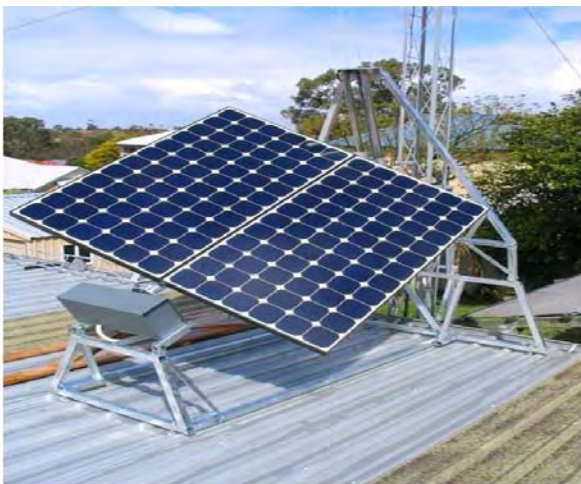
Εικόνα 2.11: Στήριξη με δυνατότητα στροφής του συλλέκτη γύρω από δύο άξονες ( http://www.solar-tracking.com/images/single_axis_icon3.png )
