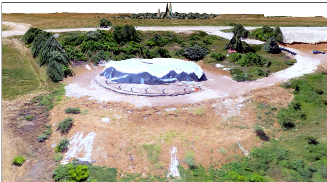
Εικόνα 13: Εσφαλμένη απόδοση οροφής τεχνικής κατασκευής και στο βάθος εσφαλμένη υψομετρική απόδοση ελαιόδεντρου (εφαρμογή eBee_agisoft_13_GCP)
