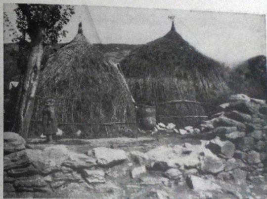
92. Κονάκια για τό κατοικιό χωρίς δεύτερη έπιπρόσθετη σκεπή τής κατοούλας: *Ανάμεσα άπ' τίς δυό καλύβες ένα γαλίκι (καρίνι), για να κουνιζούν οι κότες.
