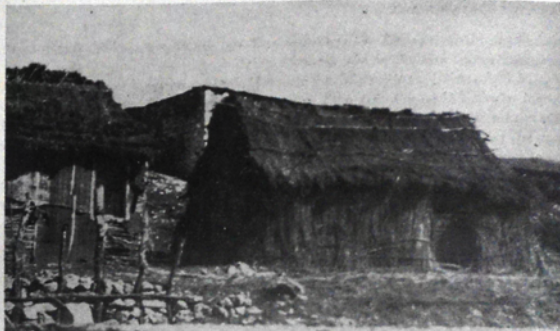
124. *Από σαρακατσάνικη κατασκήνωση που άρχιζει να γίνεται μόνιμη εγκατάσταση.— Μπροστά παραλληλόγραμμο άψιδωτό καλύβι με σαρμασσή στέγη, γινωμένο με άρνιά φουρκές (τρεις μεσιανές και έξι πλαγιανές). Το καλύβι έχει ξελιχθεί σε πλατυμέτωπο και οι άψιδωτές στενές πλευρές του είναι λιγότερο κλιμακώες.— Τό άριστοτέρο καλύβι δείχνει πύδ ξελιγμένο τρόπο κατασκευής: τό τοίχωμά του είναι επίσης βεγγόπλεστο, αλλά παραγγεμισμένο με λίσηπη (ξυλόπηστο). Τή σοβατισμένη έπιφάνειά του συχνά τήν άσβεστόνουν.— Στο βέθος διακρίνεται λιθόστιστο καλύβι, έτοιμο να σκαπωτεί με τοίγχο (δύπος στην εικ. 135).
