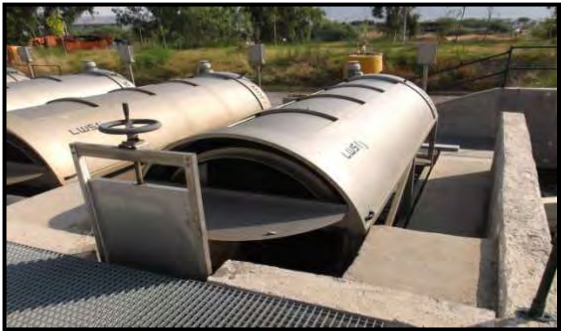
Εικόνα 21: Απολύμανση με UV
