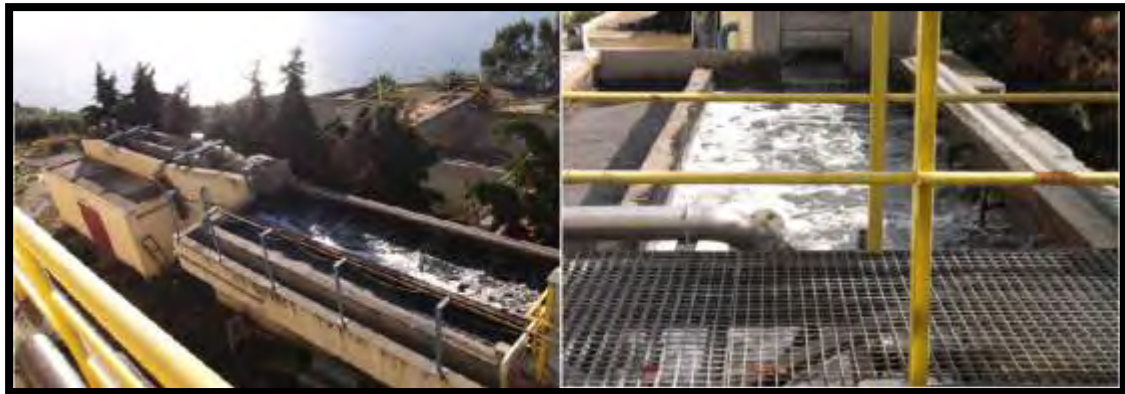
Εικόνα 8: Μονάδα αμμοσυλλογής και λιποσυλλογή
