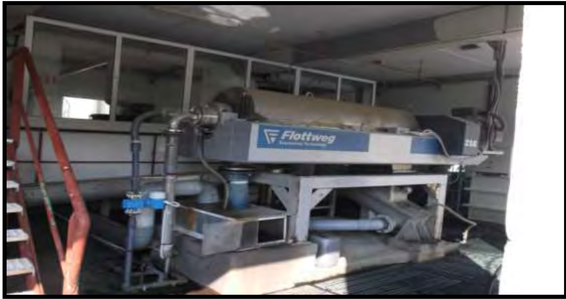
Εικόνα 19: Αφυδάτωση ιλύος με φυγοκεντρική μέθοδο.
