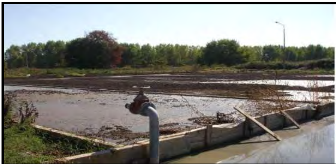
Εικόνα 17: Κλίνες ξήρανσης με μικρότερη συγκέντρωση MLSS
