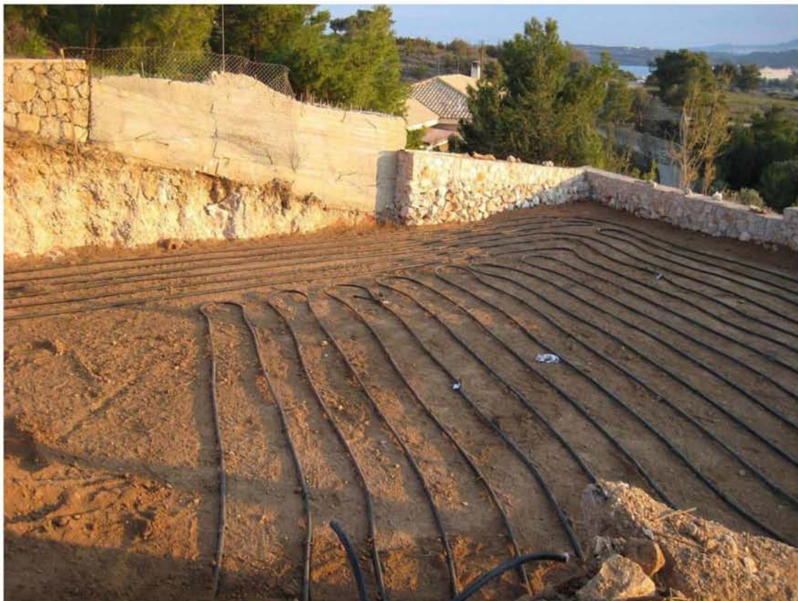
Εικόνα 3.7 Εγκατάσταση οριζόντιων εναλλακτών. (Πηγή εικόνας: [6])
