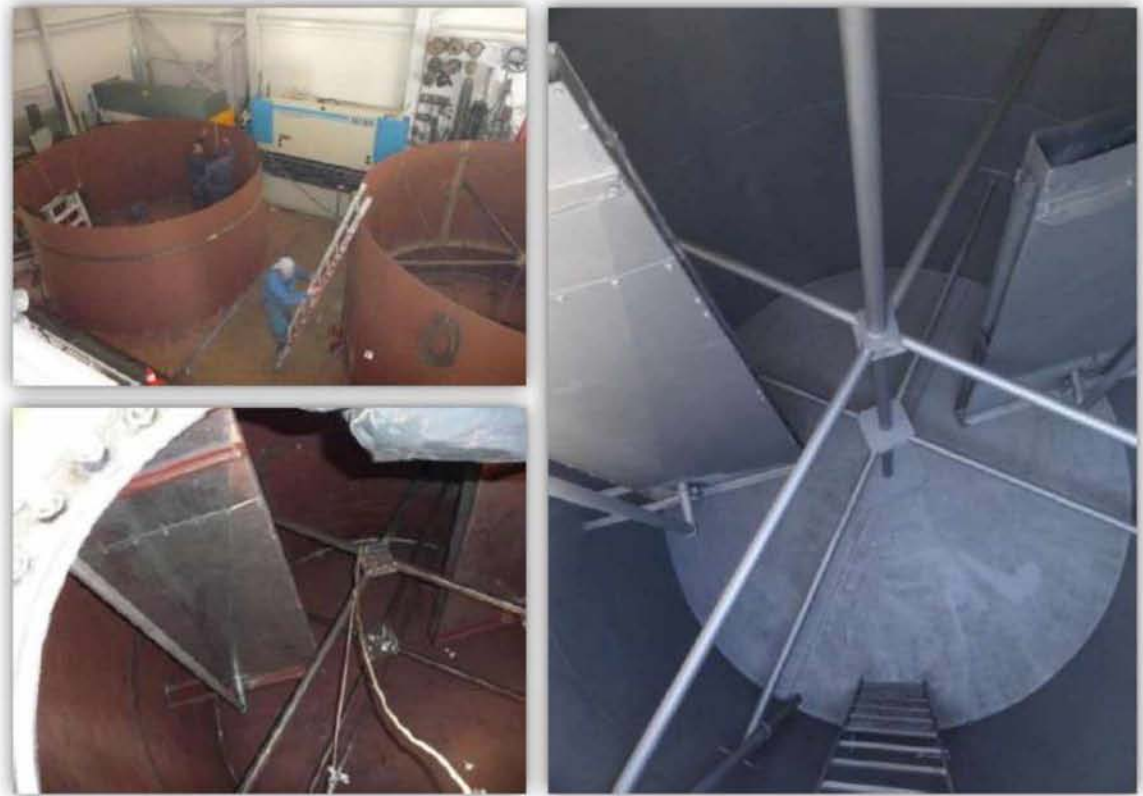
Εικόνα 6.11 Δημιουργία της υπεδαφικής αποθήκης θερμότητας. (Πηγή εικόνας: [9])
