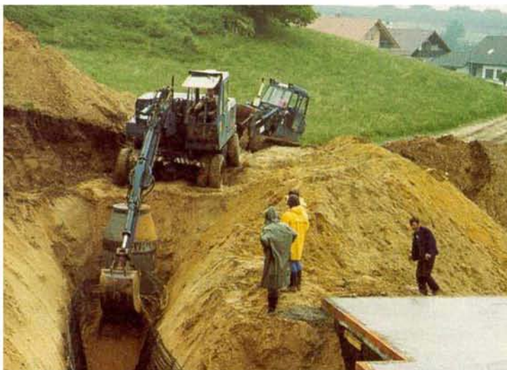
Εικόνα 4.2 Τοποθέτηση οριζόντιων σωλήνων για την εξαγωγή θερμότητας (Πηγή εικόνας: [7])
