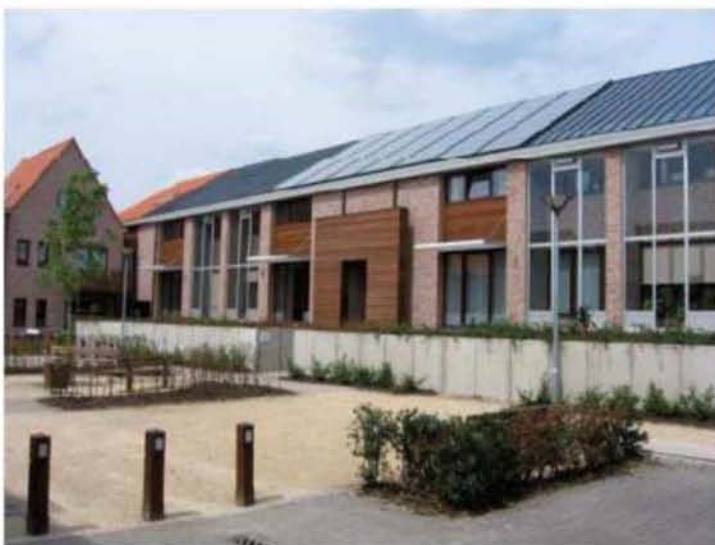
Εικόνα 6.1 (Βέλγιο) Κατοικίες με συστήματα BTES, σε συνδυασμό με ηλιακούς συλλέκτες. (Πηγή εικόνας: [8])
