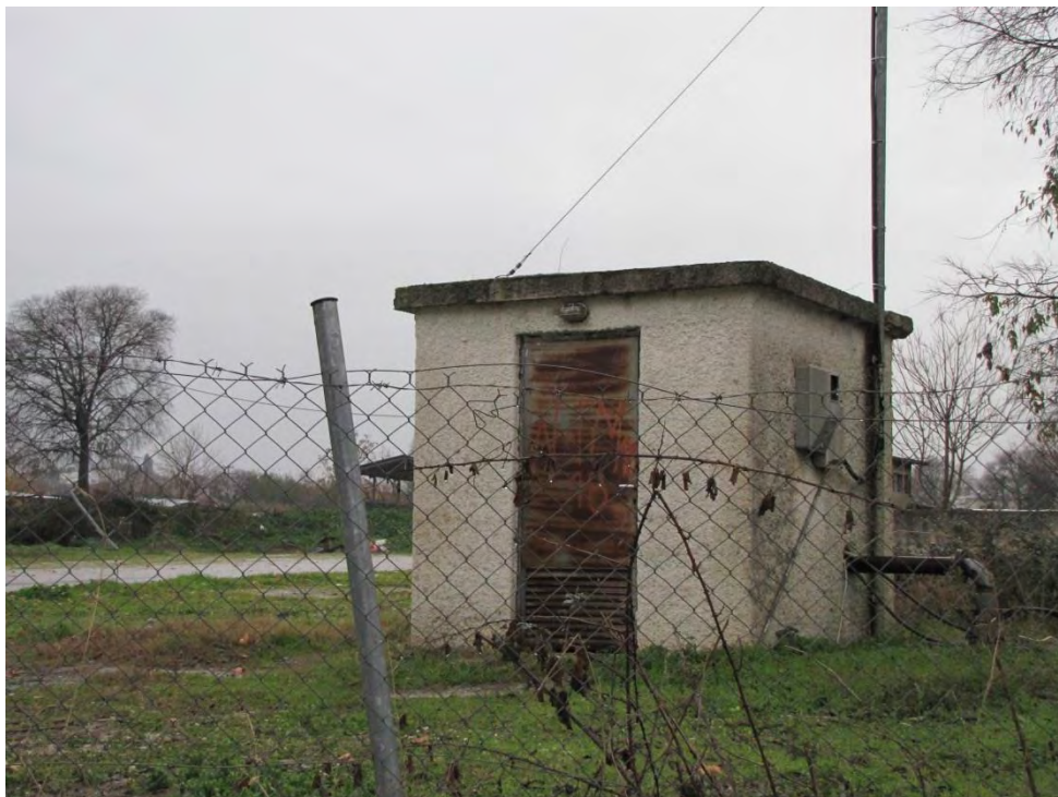
Εικόνα 3: Υδρευτική Γεώτρηση στη περιοχή του Βελεστίνου
