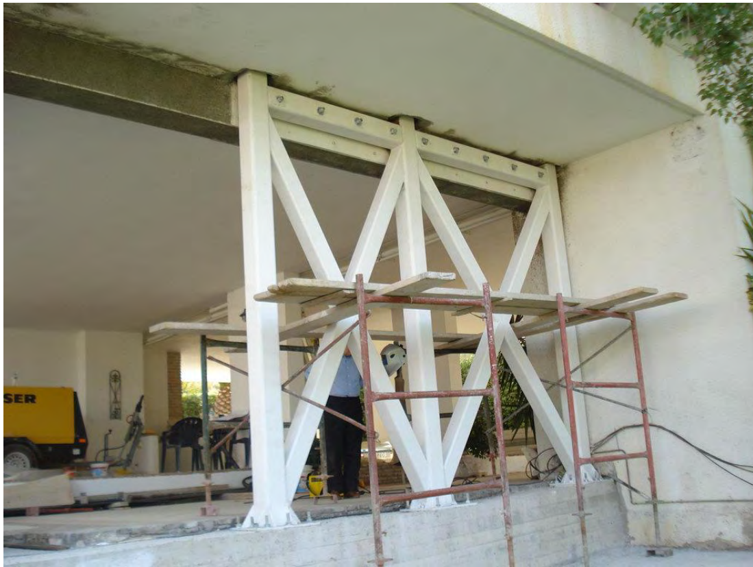
Σχήμα 1.2.2.1 : X-Μεταλλικοί σύνδεσμοι δυσκαμψίας για την ενίσχυση πλαισίων από Ο.Σ.
