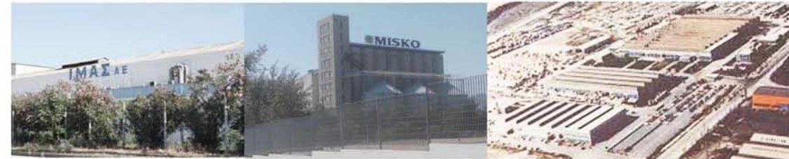
Τα εργοστάσια του ΙΜΑΣ ΑΕ, της ΜΙΣΚΟ και της Coca Cola 3E στην α' βιομηχανική περιοχή Βόλου
