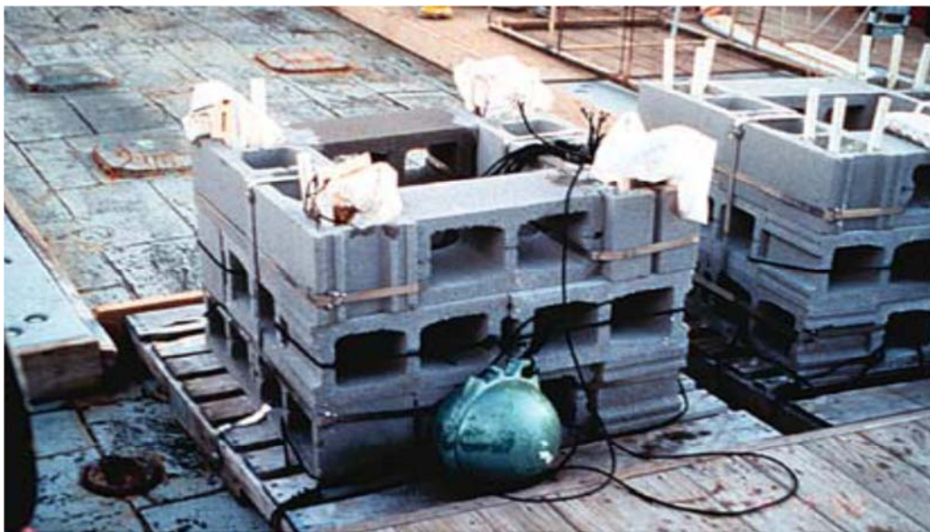
Εικόνα 5. Όγκοι σκυροδέματος με σκοπό τη δημιουργία ενδιαιτήματος για βενθικούς οργανισμούς και αποκατάσταση κοραλλιών του είδους Oculina (Seaman, 2007).
