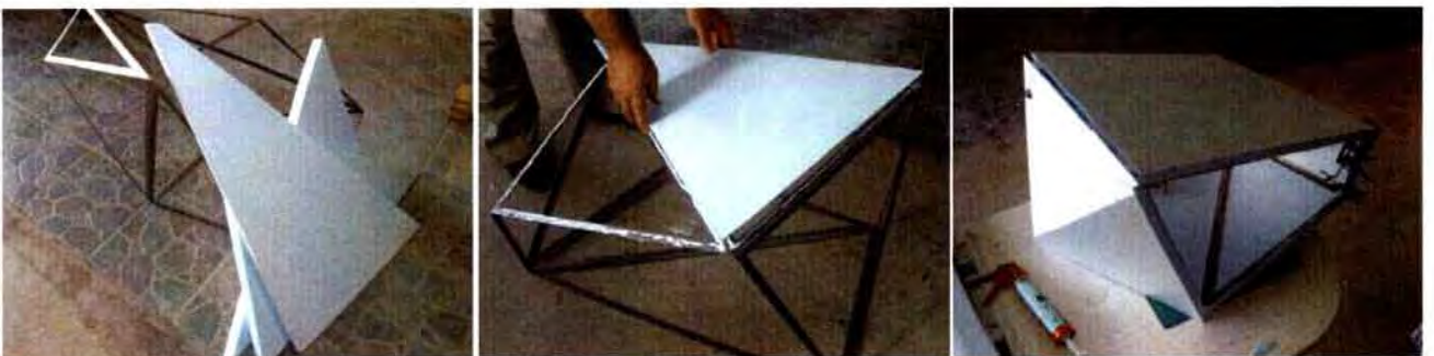
κοπή και εφαρμογή με κόλλα πάνω στον σκελετό, φύλλων μονωτικού (εξηλασμένη πολυστερίνη)
