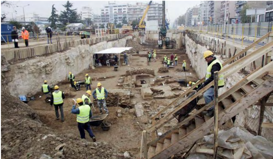
Εικόνα 3: Εργασίες κατά τη διάρκεια κατασκευής του μετρό Θεσσαλονίκης ( www.902.gr ).
