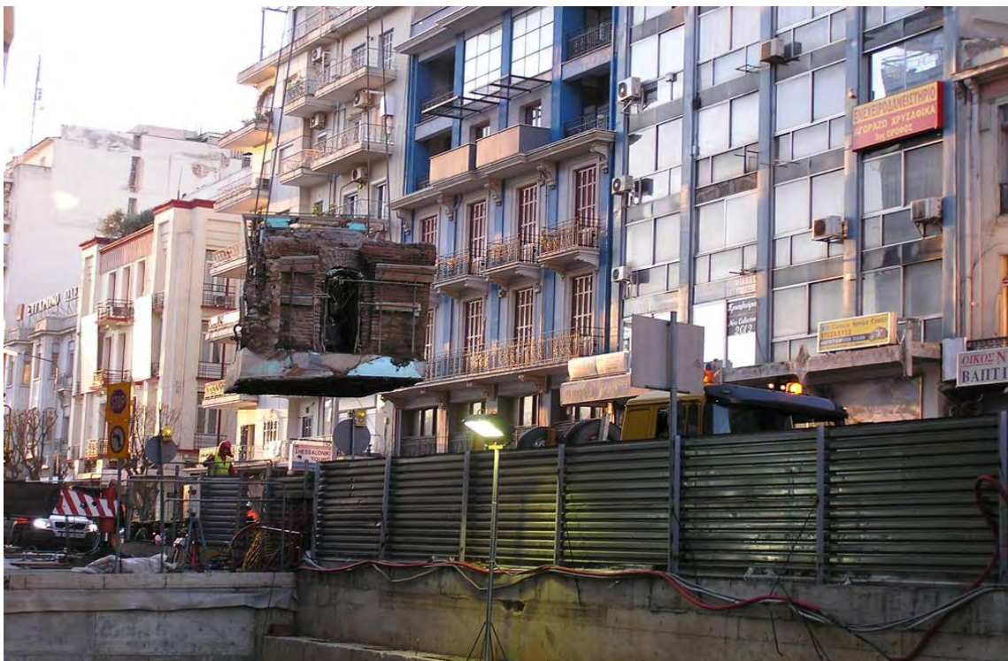
Εικόνα 4: Απόσπαση και μεταφορά καμαροσκεπών κατασκευών από τον σταθμό «Βενιζέλου» ( www.elemka.gr ).
