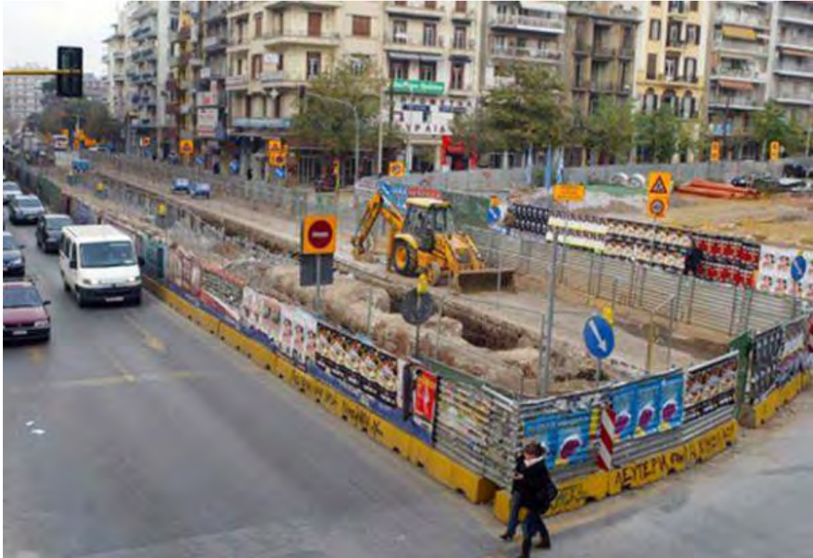
Εικόνα 5: Έργα του μετρό στο σταθμό «Βενιζέλου» καλυπτόμενα από λαμαρίνες ( www.salonicanews.com ).
