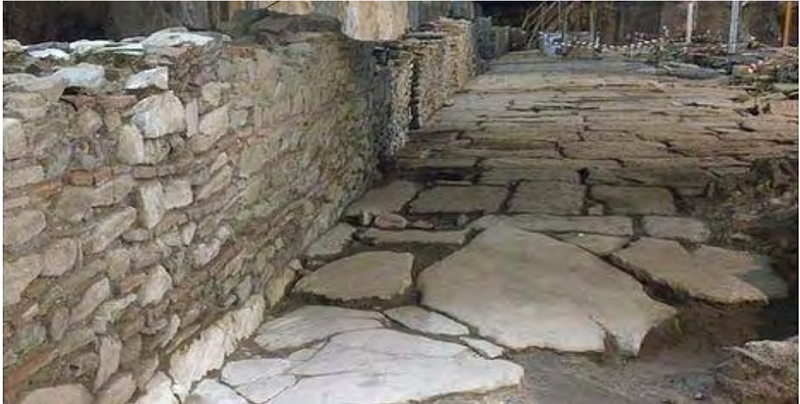
Εικόνα 1: Τμήμα της πλακόστρωτης οδού Decumanus, μήκους 76 μέτρων (Christides, 2013).
