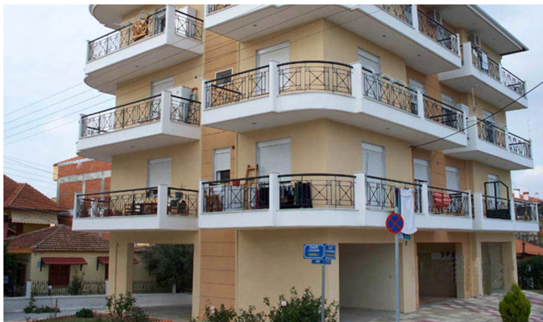
Σχήμα 1.1.1: Εξωτερική όψη πυλωτής
