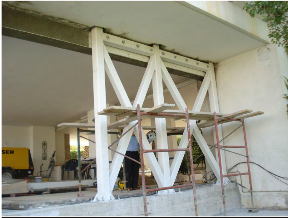
Σχήμα 1.2.2.1 : Χ-Μεταλλικοί σύνδεσμοι δυσκαμψίας για την ενίσχυση πλαισίων από Ο.Σ.
