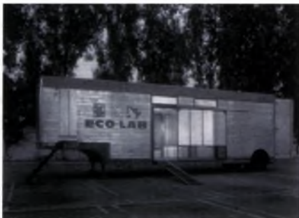
Εικ. 9. OMD's Eco Lab, κινητό κτήριο φτιαγμένο από ανακυκλωμένα υλικά
