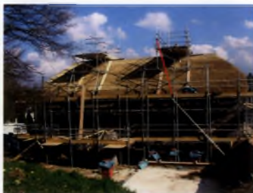
Εικ. 22. Σκαλωσιές εξωτερικά του κτηρίου
