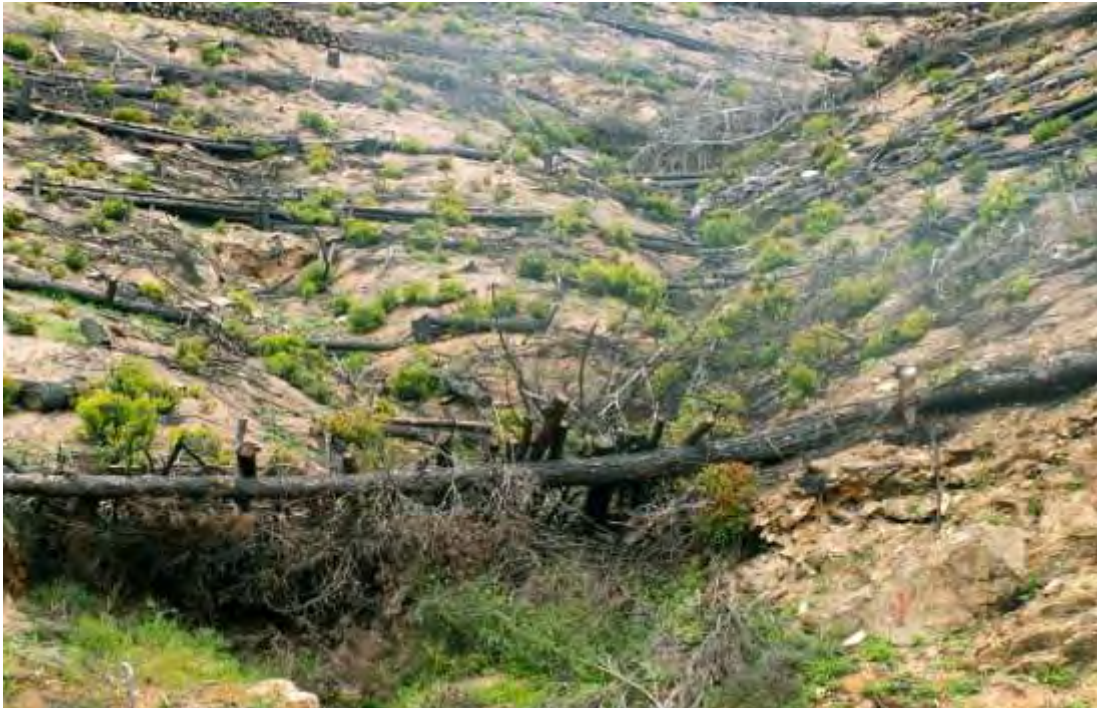
Εικόνα 4.1: Κλαδοπλέγματα και μικρά φράγματα κοντά στο φράγμα Παναγιώτικο
