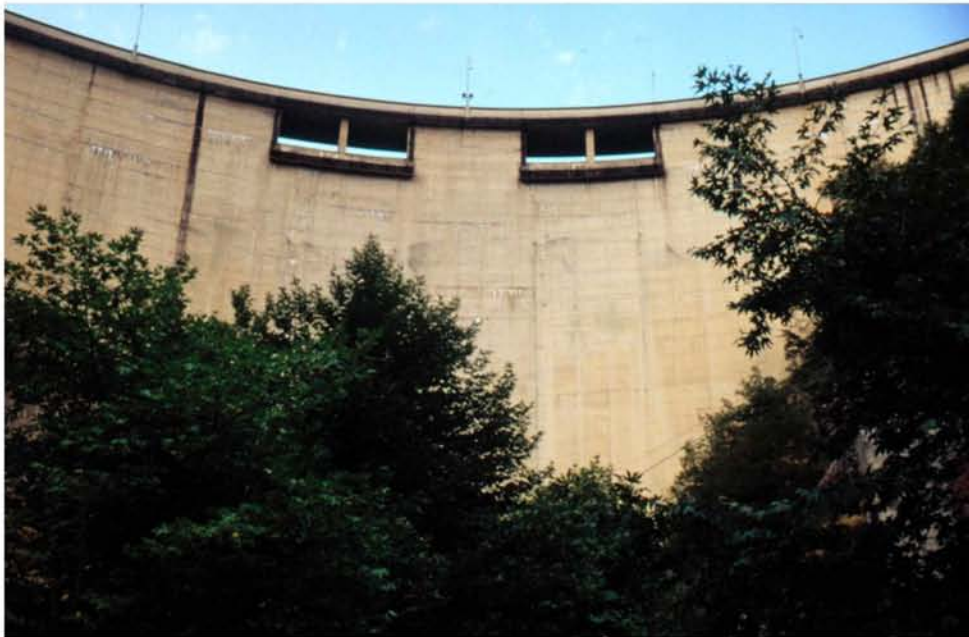
Εικόνα 6: Το φράγμα της λίμνης Ν. Πλαστήρα.
