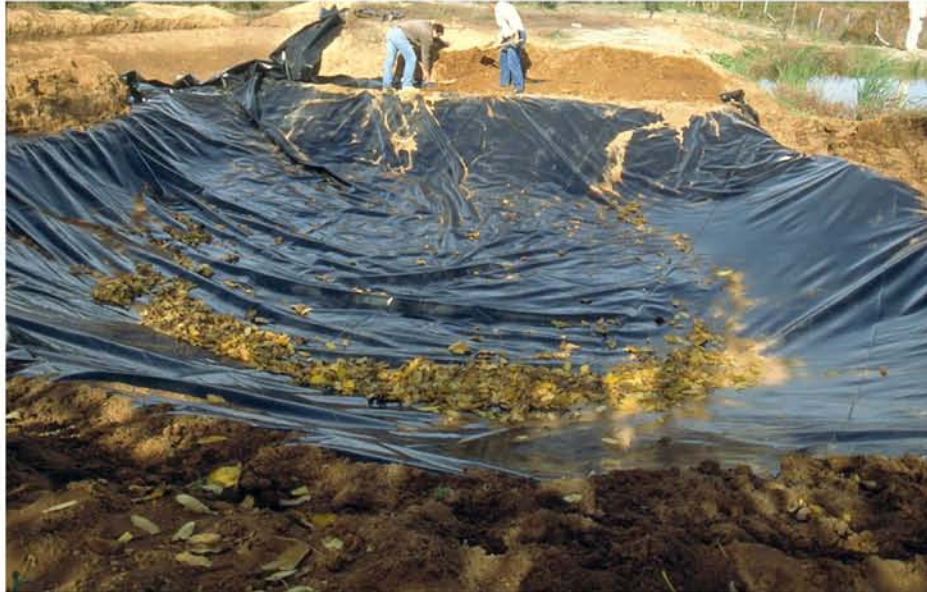
Εικόνα 66: Εργασίες κατασκευής τεχνητού υγρότοπου στο Βοτανικό Κήπο Νεοχωίου.
