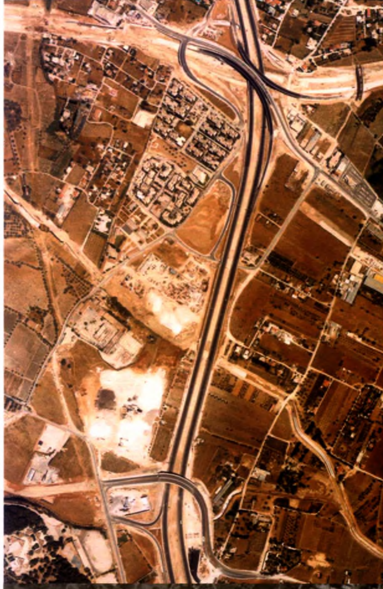
Αεροφωτογραφία της περιοχής (2001)
