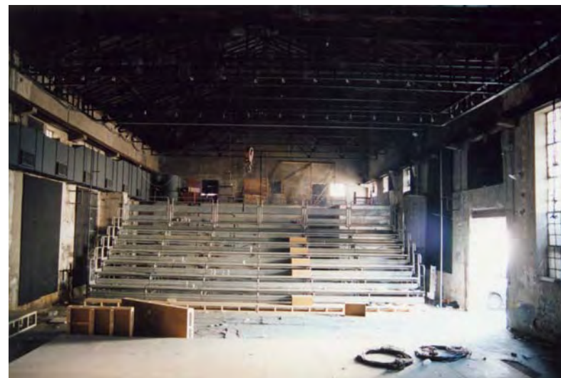
Κατά τη διάρκεια κατασκευής του θεάτρου
