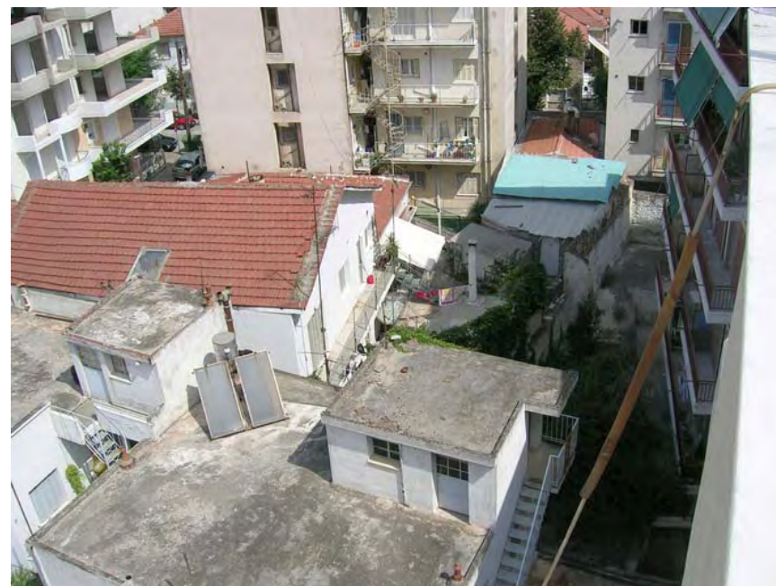
Άποψη του ακαλύπτου του 3 ου οικοδομικού
