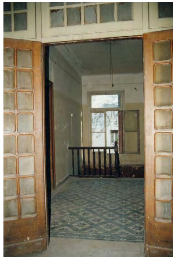
Το κλιμακοστάσιο στο ανατολικό τμήμα του κτιρίου
