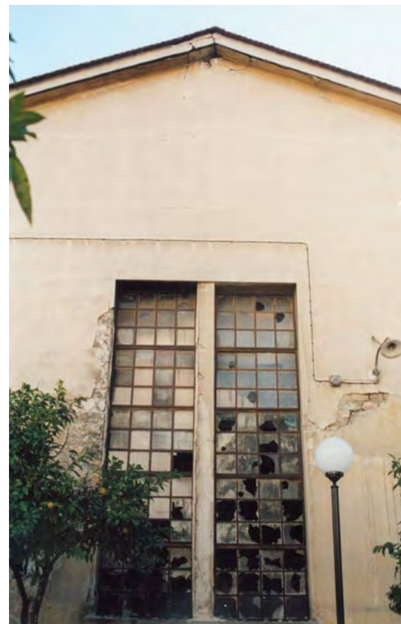
Άνοιγμα του κτιρίου επί της οδού Χατζηθανούση
