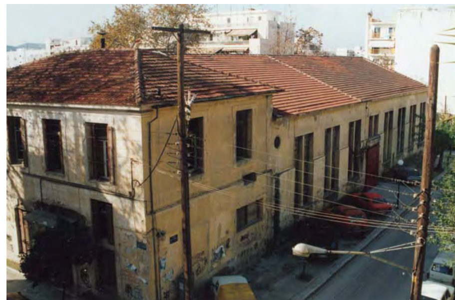
Το εργοστάσιο της Παλαιάς Ηλεκτρικής πριν από την αποκατάσταση
