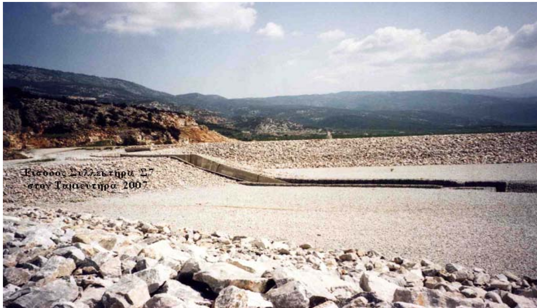
Εικόνα 80. Συλλεκτήρας Σ7 εσωτερική πλευρά
