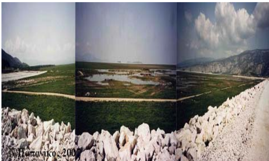
Εικόνα 61. Ο Ταμειυτήρας μετά την ολοκλήρωσή του.
