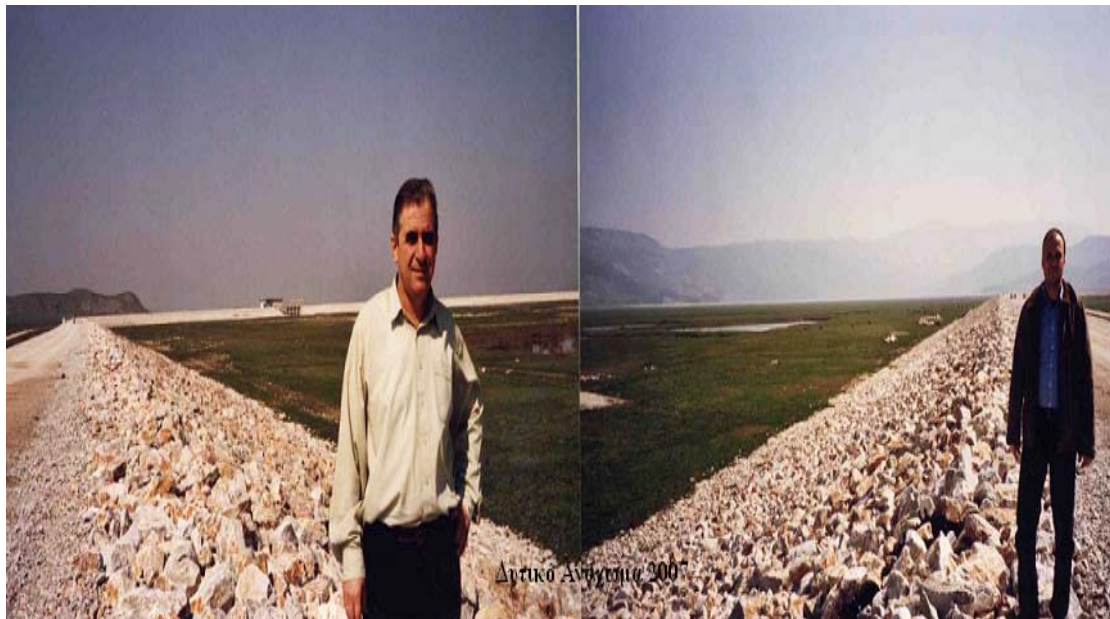
Εικόνα 56. Δυτικό ανάχωμα Ταμειυτήρα.
