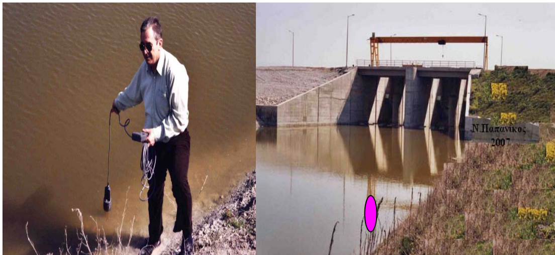
Εικόνα 52. Σταθμός δειγματοληψίας Αντλιοστασίου.
