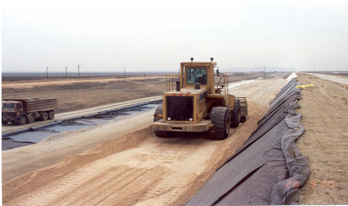
Εικόνα 60. Γεώφασμα από πολυπροπυλένιο.
