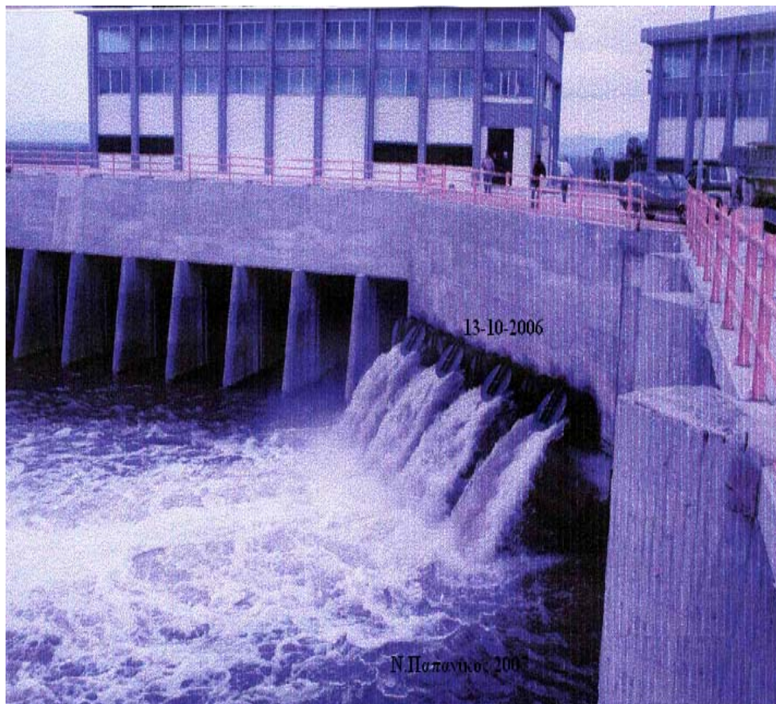
Εικόνα 67. Εσωτερική πλευρά του Αντλιοστασίου DP1.
