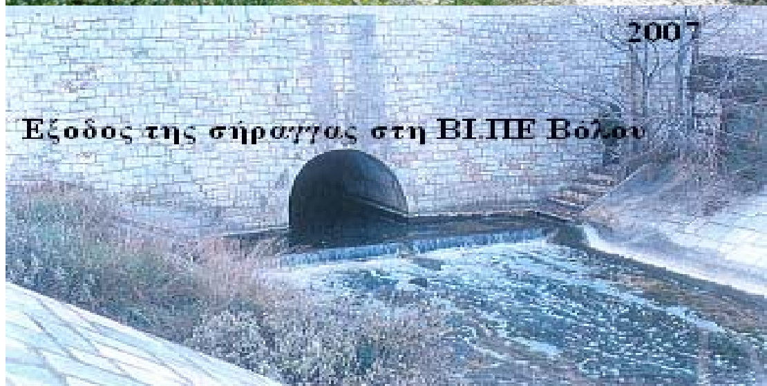
Εικόνα 42. Είσοδος και έξοδος Σήραγγας.
