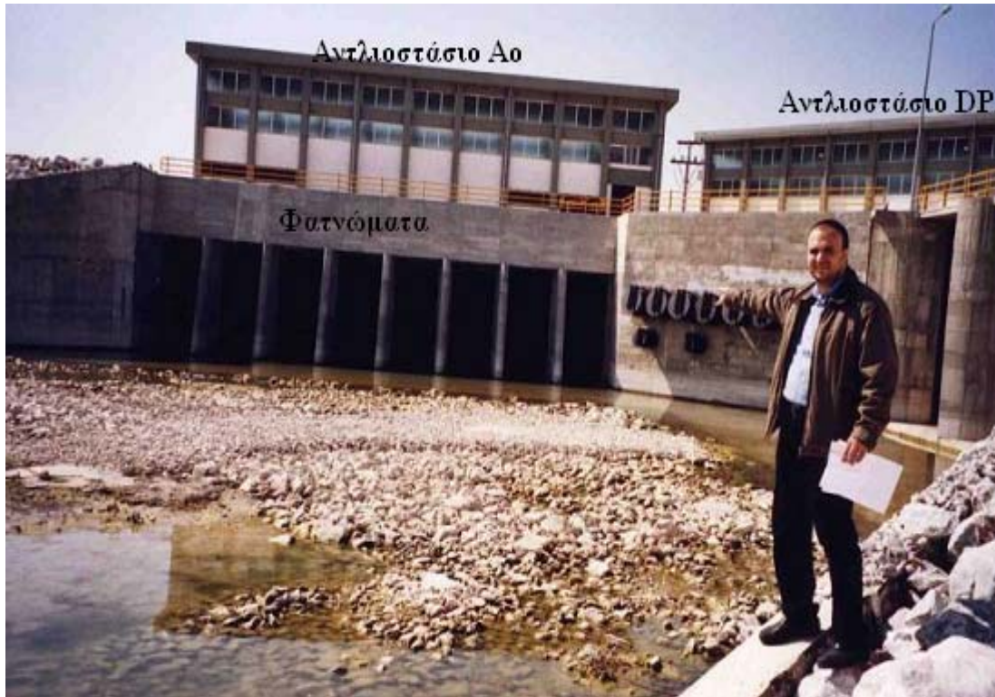
Εικόνα 64. Αντιπλημμυρικό-αποστραγγιστικό αντλιοστάσιο DP1 και άρδευσης Αο.
