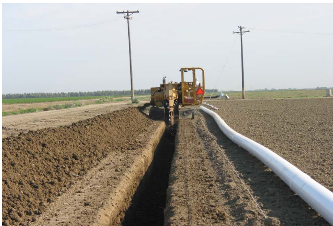
Εικόνα 94. Εγκατάσταση μονίμων αρδευτικών δικτύων.
