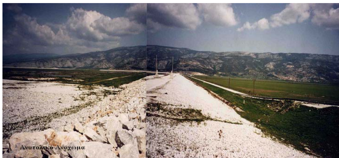
Εικόνα 55. Ανατολικό ανάχωμα Ταμιευτήρα
