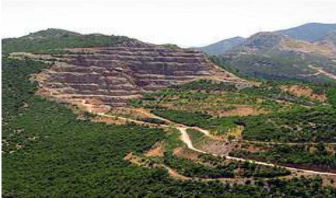
Εικόνα 8. Εκμετάλλευση με βαθμίδες στην Γκιώνα
