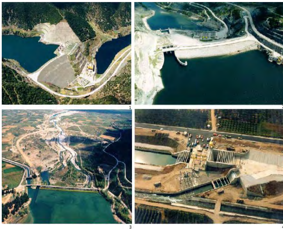
Εικόνα 3.16: 1. ΥΗΣ Σφηκιάς, 2. ΥΗΣ Ασωμάτων, 3. Έργο Αγίας Βαρβάρας, 4. Μικρός ΥΗΣ (Πηγή: www.dey.gr , 10/10/2012)
