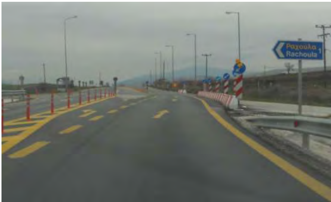
Εικόνα 4.8: Στη χ.θ. 8+600 ισόπεδος κόμβος για Ραχούλα με διαμόρφωση αριστερόστροφων κινήσεων
