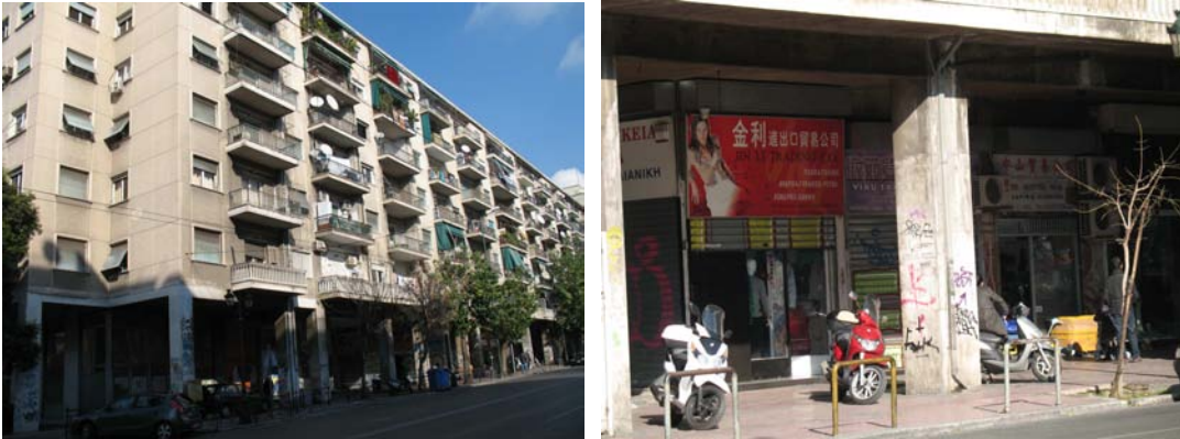
Εικ. 32, 33 Αριστερά: Κατοικίες της κινέζικης κοινότητας στην Chinatown επί της Πειραιώς Δεξιά: Κινέζικα καταστήματα στην Chinatown επί της Πειραιώς
