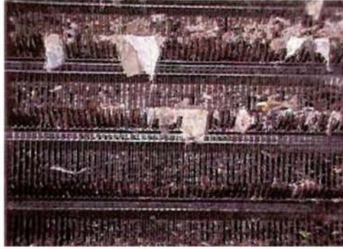
Εικόνα 4.7.1.1.1. Σχάρες συγκράτησης στερεών αντικειμένων (Ράμμος Ι., 2006).
