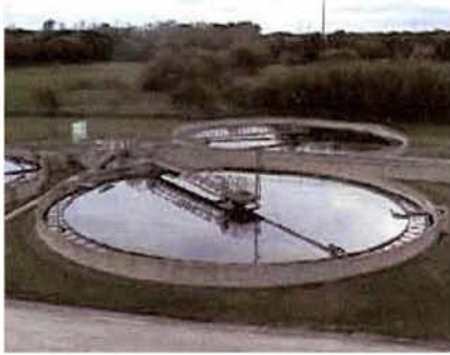
Εικόνα 4.7.1.2.1. Δεξαμενές καθιζήσεως (Ράμμος Ι., 2006)
