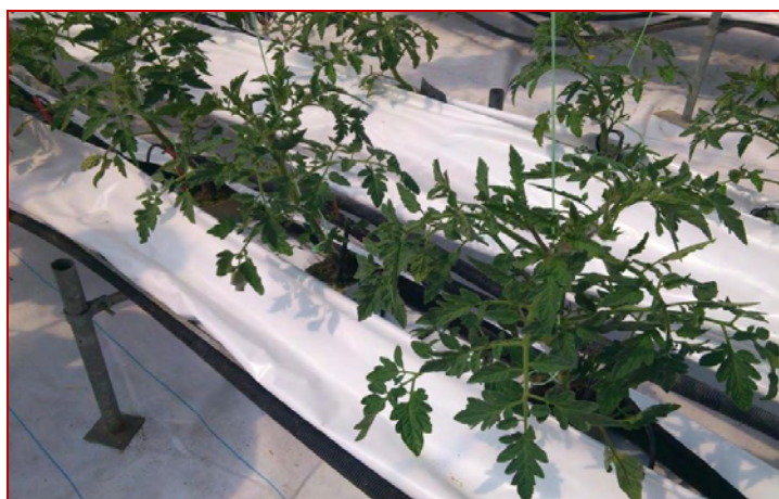
Εικ. 3.3. Οι σωλήνες θέρμανσης
