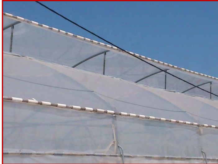
Εικ . 3.2. ο αερισμός του θερμοκηπίου στην περιοχή του Βελεστίνου
