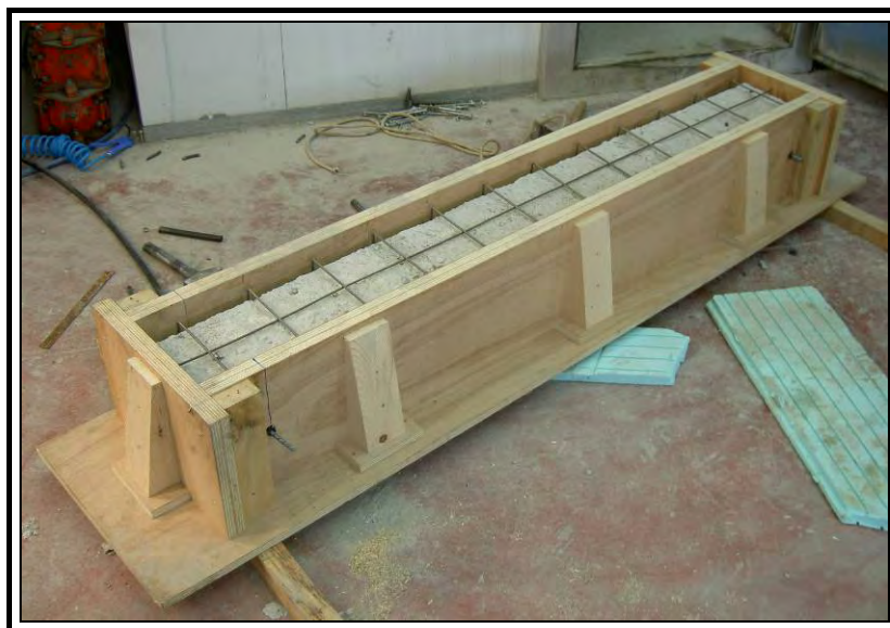
Σχήμα 2.7 - Συμβατικά οπλισμένη δοκός με πλέγμα T131 στον ξυλότυπο λίγο πριν τη σκυροδέτηση του ινοπλισμένου μανδύα.
