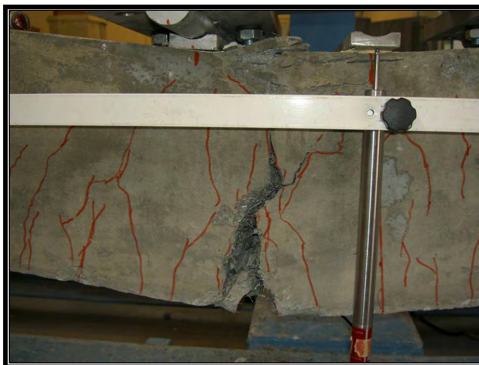
Σχ. 3 - Λεπτομέρεια της περιοχής αστοχίας.
