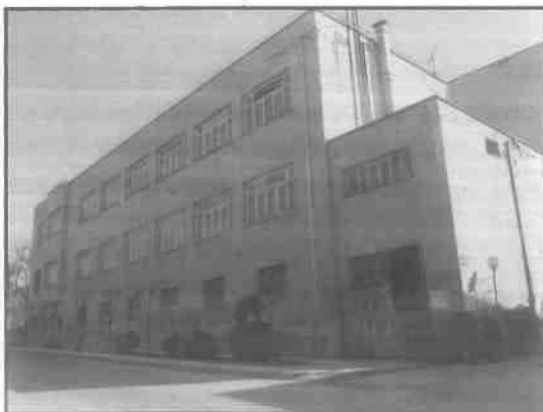
Η βόρεια πλευρά του Γυμνασίου
