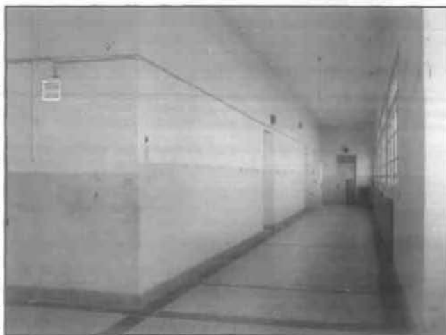
Ο διάδρομος του ισογείου
