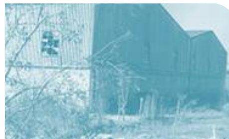
Εικόνα 2: Εργοστάσιο Παπαρήγα - κτίριο αποθήκης έτοιμου προϊόντος.
