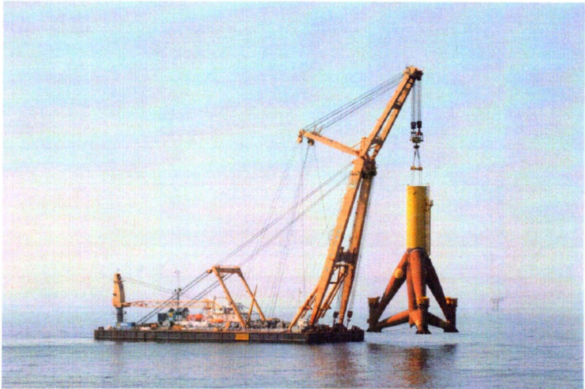
Σχήμα 4.6) Εικόνα από τρίποδο θεμέλιο να εισέρχεται στην θάλασσα ( Πηγή: Walkemeyer, 2010)
