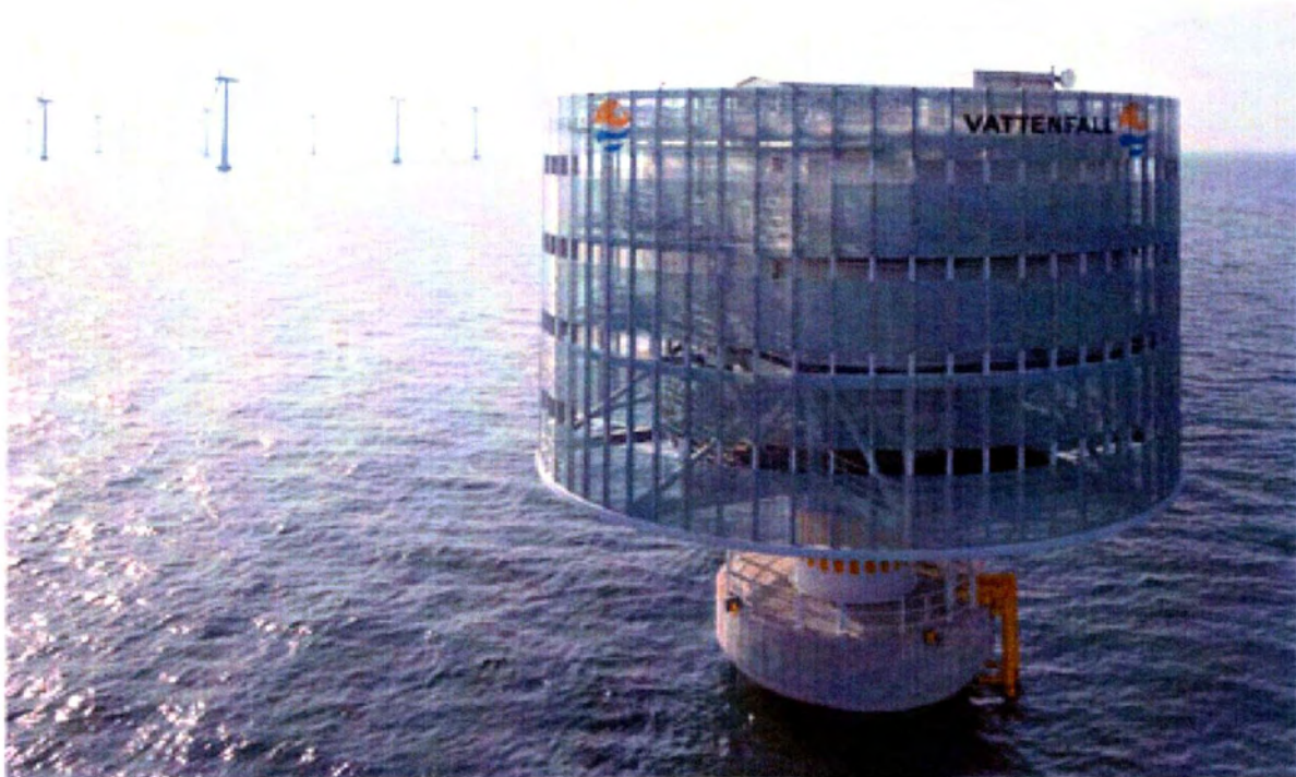
Σχήμα 4.8) Εικόνα από τον υπεράκτιο υποσταθμό στο αιολικό πάρκο του Lillgrund (Πηγή: http://www.siemens.com/ )
