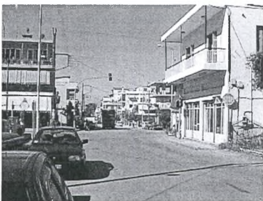
Φωτογραφία XII.4. Άποψη κόμβου από την οδό Ταυγέτου (Ανατολή)
