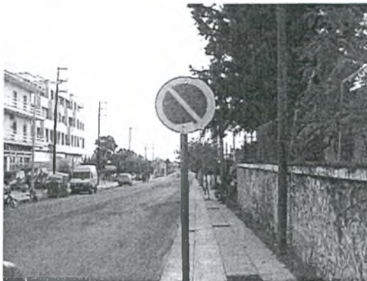
Φωτογραφία Χ.8. Κακή κατάσταση στοιχείων κατακόρυφης σήμανσης
