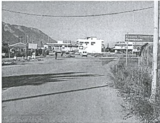
Φωτογραφία XIV.2. Άποψη κόμβου από την οδό Ταυγέτου (Ανατολή)
