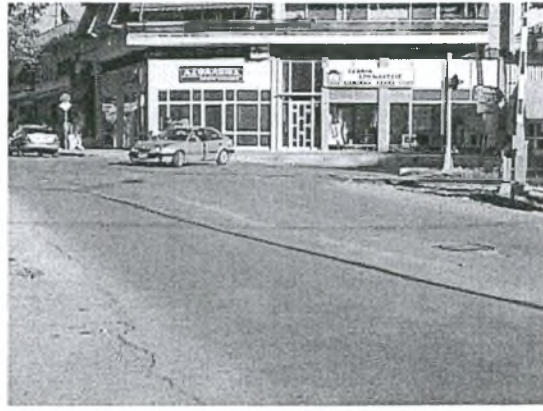
Φωτογραφία VIII.5. Απότομη αλλαγή κλίσης επί της οδού Θερμοπυλών
