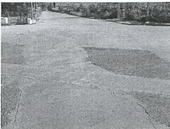
Φωτογραφία XIV.8. Τοπική ανισοσταθμία λόγω επικαλύψεων και επωθήσεων
