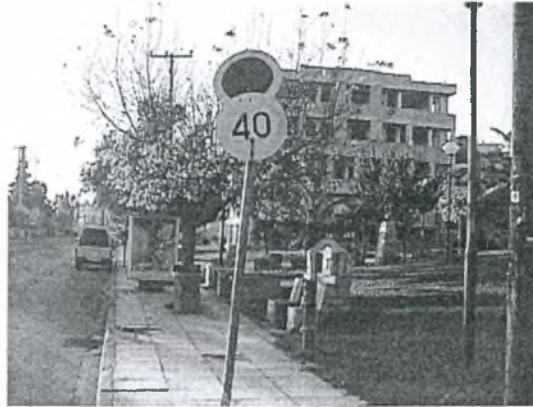
Φωτογραφία Χ.7. Κακή κατάσταση στοιχείων κατακόρυφης σήμανσης
