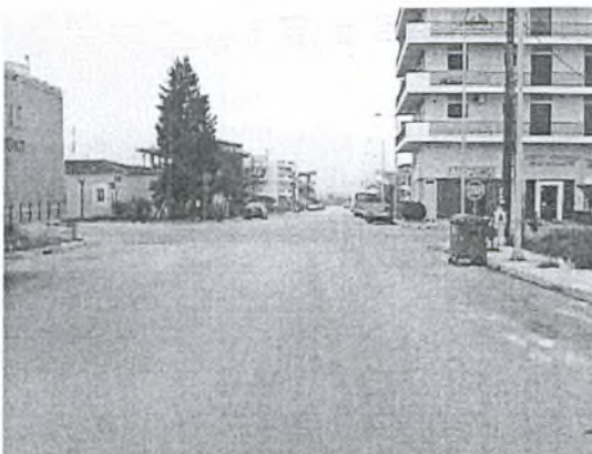
Φωτογραφία XIII.4. Άποψη κόμβου από την οδό Μ. Αλεξάνδρου (Βορράς)
