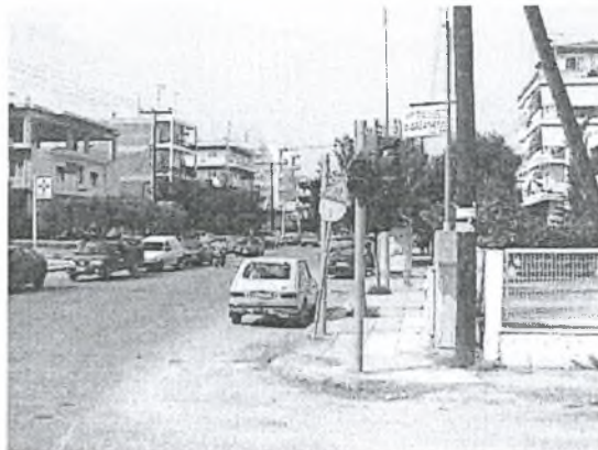
Φωτογραφία ΙΙΙ.8. Προβληματική κατάσταση της κατακόρυφης σήμανσης
