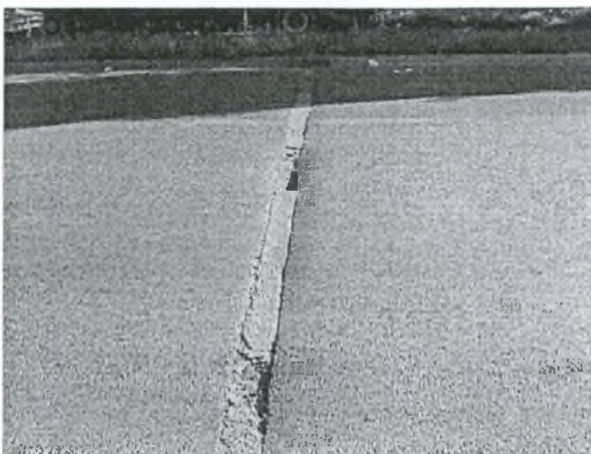
Φωτογραφία XIV.7. Μπαλώματα επί του οδοστρώματος
