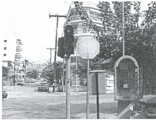
Φωτογραφία ΙΙΙ.9. Προβληματική κατάσταση της κατακόρυφης σήμανσης
