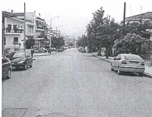
Φωτογραφία IV.2. Άποψη κόμβου από την οδό Γ.Πλατή (Ανατολή)
