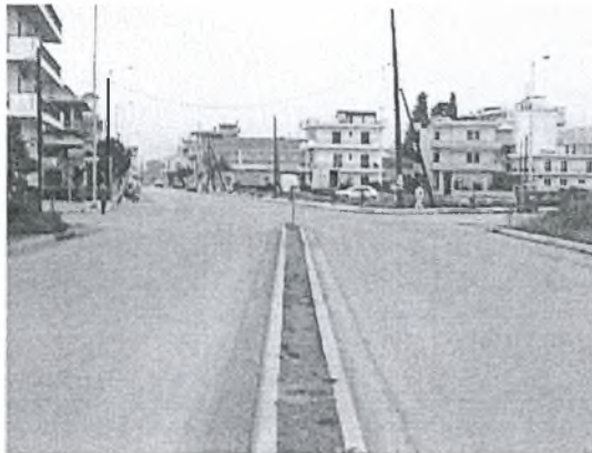
Φωτογραφία XIII.2. Άποψη κόμβου από την οδό Ταΰγετου (Ανατολή)
