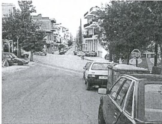
Φωτογραφία IV.10. Προβληματική θέση σήματος STOP
