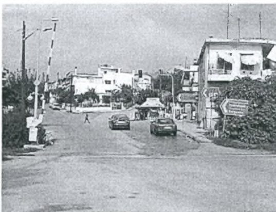
Φωτογραφία 1.3. Άποψη κόμβου από την οδό Κύπρου (Νότος)
