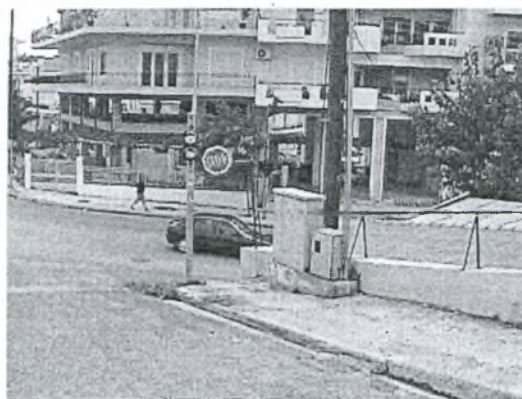
Φωτογραφία 1.15. Κακή θέση και κατάσταση σήματος STOP
