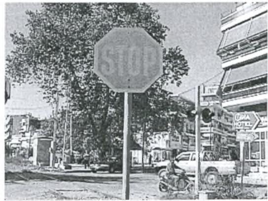
Φωτογραφία VIII.7. Κακή κατάσταση πινακίδας STOP
