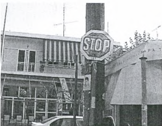
Φωτογραφία XI.4. Κακή κατάσταση σήματος STOP
