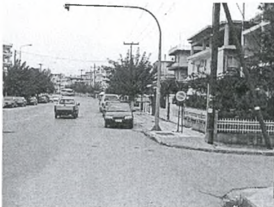
Φωτογραφία ΙΙ.6. Κακή κατάσταση σήματος απαγόρευσης στάθμευσης
