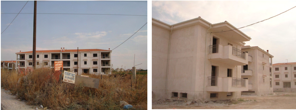
Εικόνα 43α, β, Κατασκευή νέων κατοικιών στο προάστιο της Γιάννουλης
