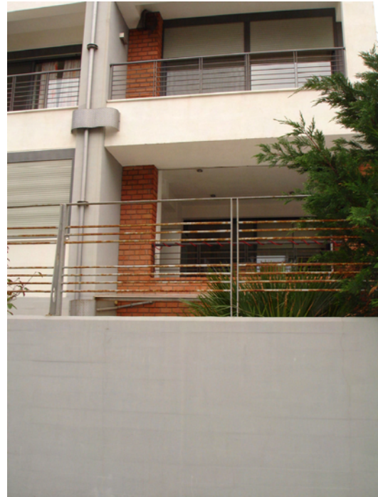
Εικόνα 68, Ενδιαφέρουσα όψη κατοικίας με μινιμαλιστικό συνδυασμό υλικών
