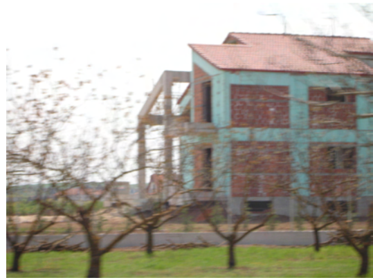
Εικόνα 94, κατοικία στη φάση της κατασκευής
