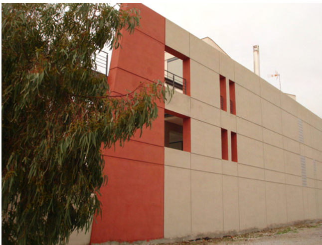
Εικόνα 66, Όριο κατοικίας με το συνηθισμένο τοίχο από οπλισμένο σκυρόδεμα, αποδομένος με ιδιαίτερο τρόπο ωστόσο.
