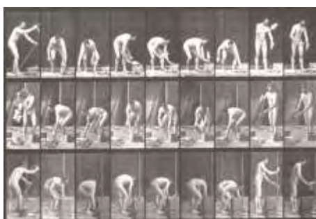
Εικ. 24 Eadweard Muybridge «Χτίστης τούβλων», ( Bricklaying ), Plate 505 from Animal Locomotion (1887)
