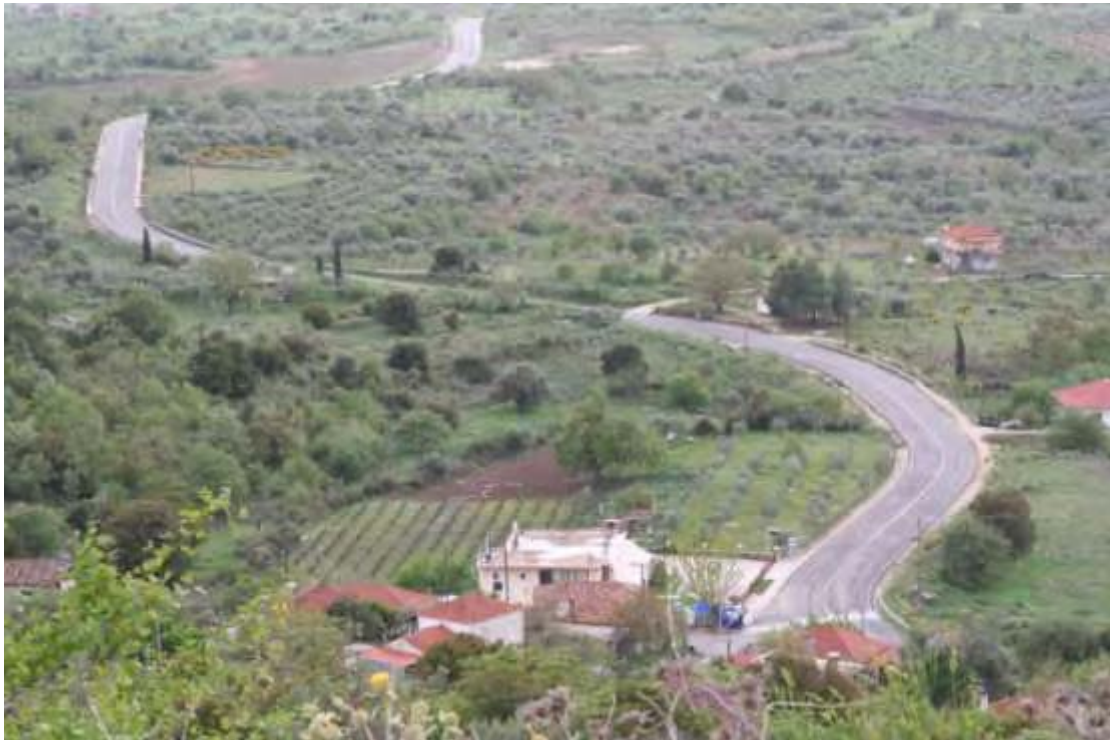
Θέση 5: Σύνδεση με το υφιστάμενο οδικό τμήμα έξω από τον οικισμό Τουλούπα Χάνι που διακρίνουμε στην φωτογραφία. Ολοκλήρωση του νέου έργου.
