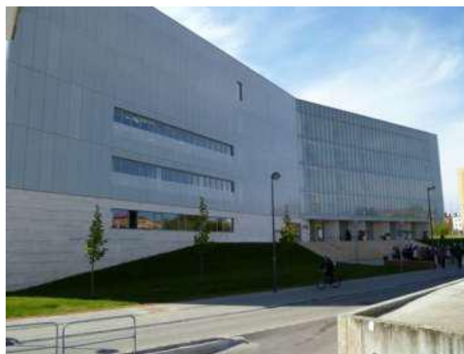
Εικόνα 2.2: Περιφερειακή Βιβλιοθήκη & Κέντρο Μελέτης, Πεκς
