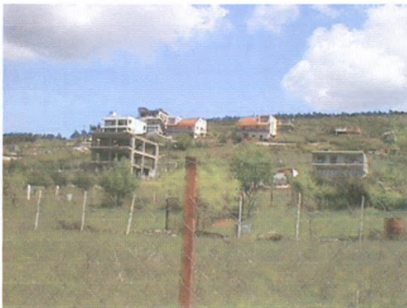
ΦΩΤΟΓΡΑΦΙΑ 11. Αυθαίρετες κατοικίες που θα απαλλοτριωθούν για να διέλθει η Ανατολική Περιφερειακή οδός.
