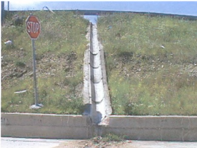
ΦΩΤΟΓΡΑΦΙΑ 16. Ρεϊθρο για αποφυγή διάβρωσης του επιχώματος από όμβρια.
