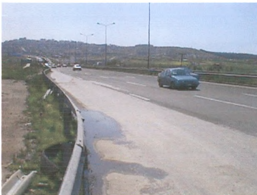
ΦΩΤΟΓΡΑΦΙΑ 3. Λωρίδα επιβράδυνσης της Εσωτερικής Περιφερειακής που οδηγεί στην είσοδο του Νοσοκομείο Παπαγεωργίου.
