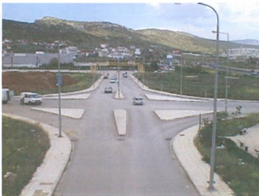
ΦΩΤΟΓΡΑΦΙΑ 14. Ισόπεδος κόμβος στα πολυκαταστήματα Carrefour για την είσοδο ή έξοδο στην Εσωτερική Περιφερειακή.
