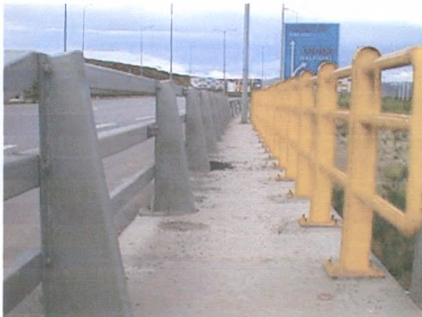
ΦΩΤΟΓΡΑΦΙΑ 8. Στηθαία ασφαλείας σε άνω διάβαση. Θα χρησιμοποιηθούν στην κατασκευή των άνω διαβάσεων (γεφυρών) των τριών τεχνικών έργων του ανισόπεδου κόμβου
