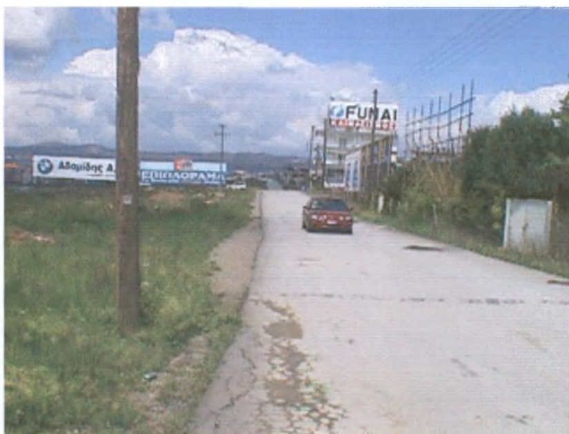
ΦΩΤΟΓΡΑΦΙΑ 13. Παράπλευρη οδός που εξυπηρετεί τις χρήσεις γης (οικισμός) ανατολικά του Carrefour.
