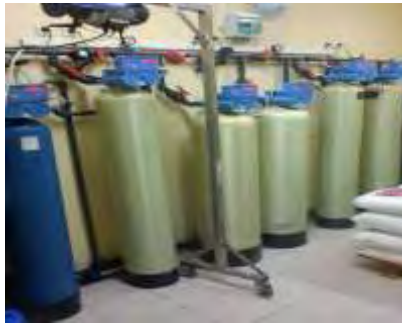
Εικόνα 10.2. Φίλτρα άμμου – Αποσκληρυντές – Φίλτρα ενεργού άνθρακα
