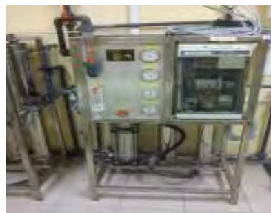
Εικόνα 10.4. Μηχανισμός αντίστροφης όσμωσης
