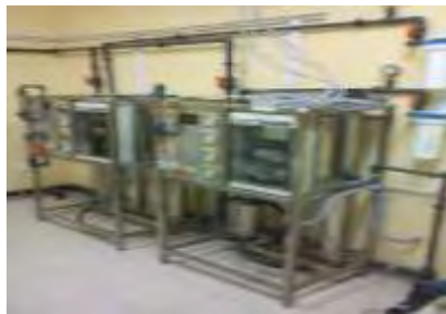
Εικόνα 10.5. Συσκευή διπλής αντίστροφης όσμωσης
