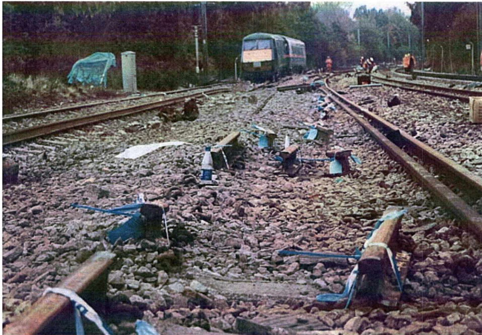
Σχήμα 1.1 Ολική θραύση της σιδηροτροχιάς στο δυστύχημα του Hatfield [5]
