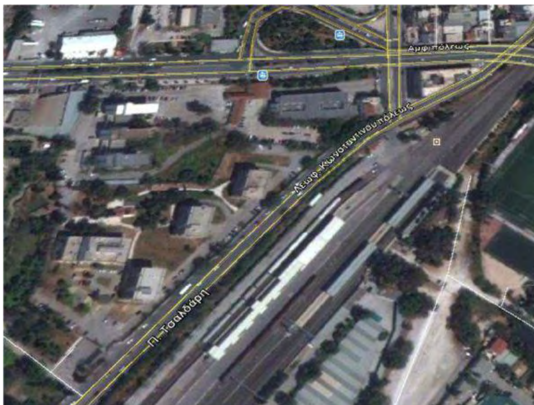
Εικόνα 9: Εγκαταστάσεις ΤΡΑΙΝΟΣΕ στο Ρουφ
