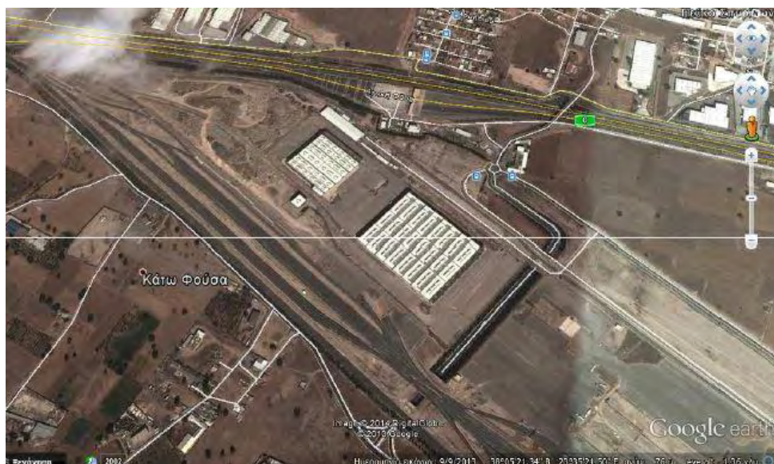
Εικόνα 8: Εγκαταστάσεις ΤΡΑΙΝΟΣΕ στο Θριάσιο
