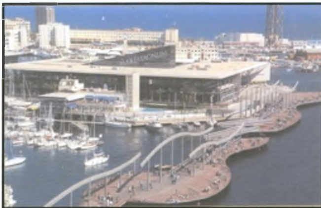
Εικόνα 2.4: Άποψη του φόρουμ των πολιτισμών Πηγή: (Γεωργανάς, 2005)
