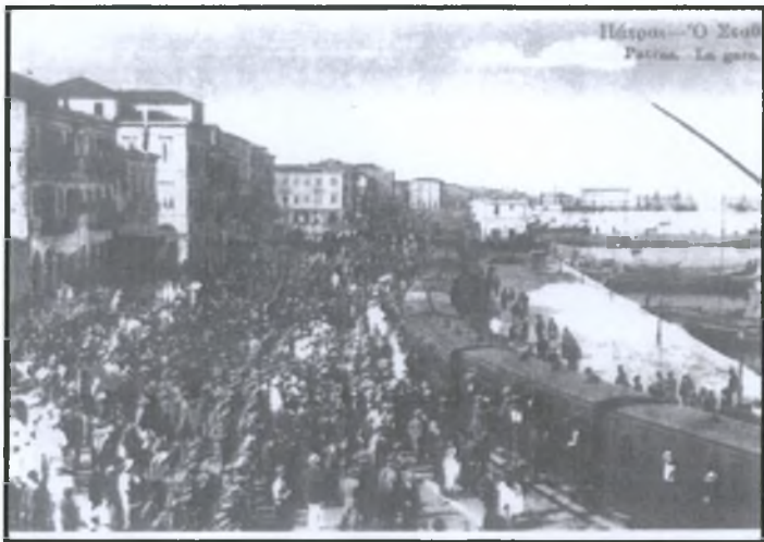
Εικόνα 3.9: Αποψη της σιδηροδρομικής γραμμής, πηγή: (Α.Κοκκοβίκας, 2002)
