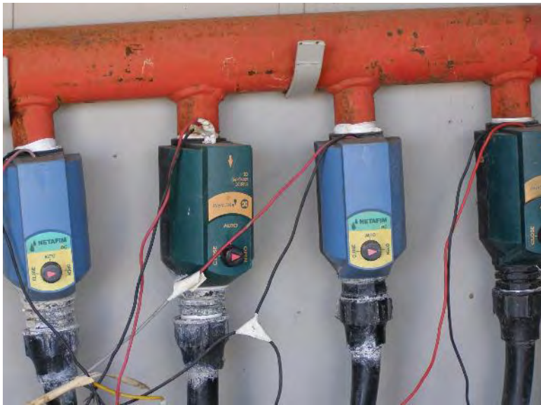
Εικόνα 2.20: Ηλεκτροβαλβίδες.
