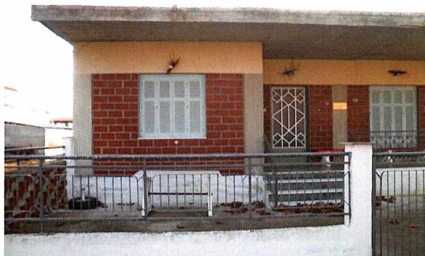
Εικόνα 77,78 Σκυροδετημένος Αύλειος Χώρος Αυθαιρέτης Κατασκευής
