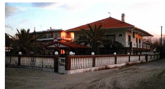
Εικόνα 64 Εκκλησιαστική Ιδιοκτησία _Αυθαίρετη Επέκταση Αύλειου Χώρου ΕΝΤΟΣ Αιγιαλού
