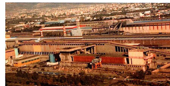
Εικόνα 42 Αυθαίρετη Εγκατάσταση Εργοστασιακής Μονάδας που γεινιάζει με Κατοικημένη Περιοχή Εκτός Σχεδίου Πόλης _Κίνδυνος μολύνσεων και επιδημιών
