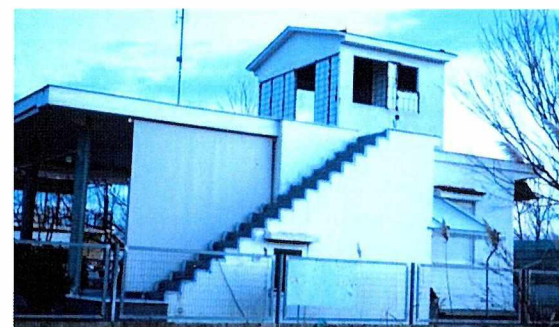
Εικόνα 71 Αυθαιρέτη Καθ' Ύψος Κατασκευή _ «Κινούμενο» - Μισοτελειωμένο Κτίσμα
