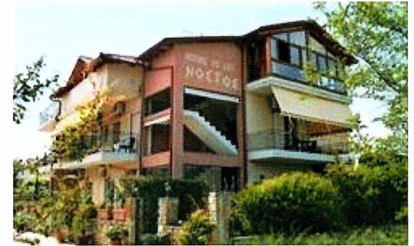
Εικόνα 37 Αυθαίρετη Κατασκευή κατοικίας _Αλλαγή χρήσης για επαγγελματική εκμετάλλευση _περιοχή Μεσαγγάλων
