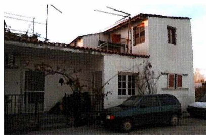
Αρχικό κτίσμα με επέκταση σε όροφο
