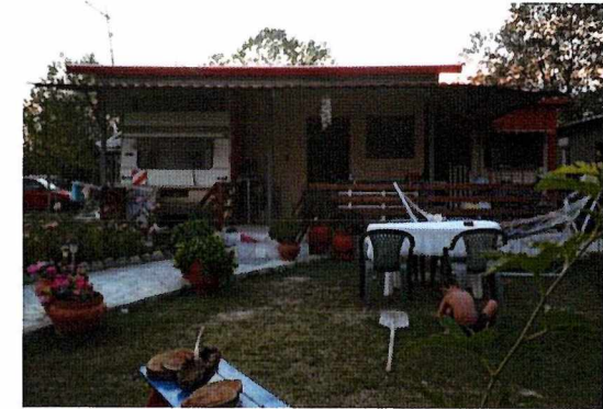
Εικόνα 137 Σταδιακή επέκταση αυθαιρεσίας στον οριζόντιο άξονα
