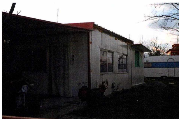
Εικόνα 83,84 Αυθαίρετη Κατασκευή με Μεταλλικά Panels Πλήρωσης
