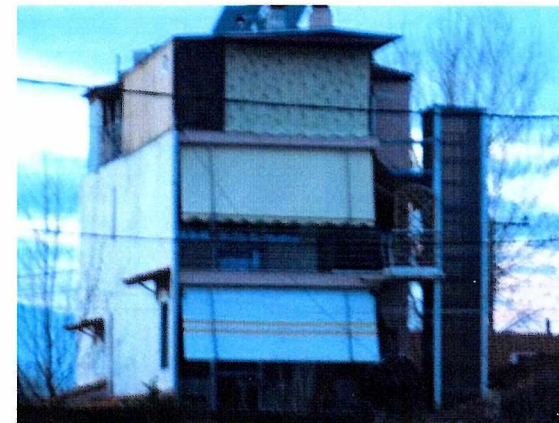
Εικόνα 69 Ολοκληρωμένη Επέκταση Καθ' Ύψος της Αυθαιρέτης Κατασκευής
