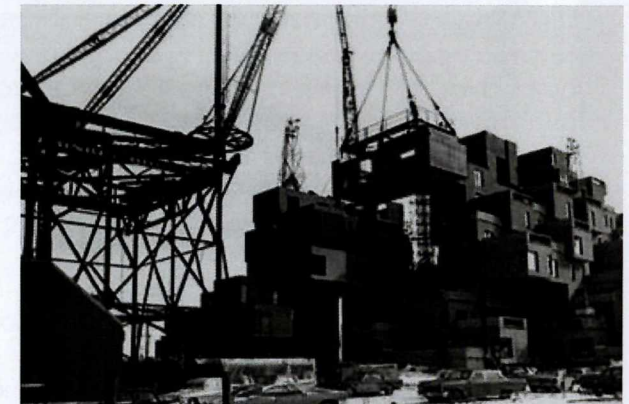
Εικόνα 177 Τοποθέτηση προκατασκευασμένων μονάδων
