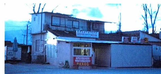
Εικόνα 60 Αυθαίρετο-Επαγγελματικός Χώρος με Οριζόντια και Κατακόρυφη Επέκταση
