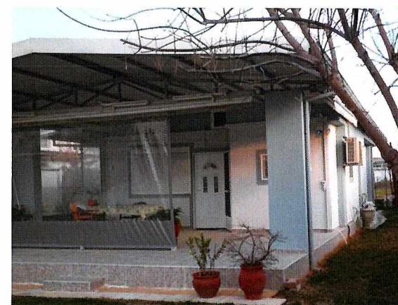
Εικόνα 68 Αυθαίρετη Κατασκευή _«Κινούμενο» - Μισοτελειωμένο Κτίσμα
