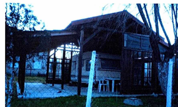
Εικόνα 67 «Εν Δυνάμει» Επέκταση _Αυθαίρετο Στέγαστρο και κλείσιμο της μιας πλευράς του
