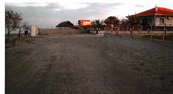
Εικόνα 65 Παραλιακός Δρόμος _Διακόπτεται από Αυθαίρετη Επέκταση Ξενοδοχείου
