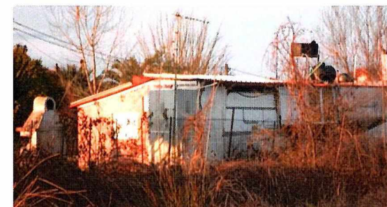
Εικόνα 76 Επέκταση Αυθαίρετης Κατασκευής που Εγκολπώνει το Αρχικό Κατάλυμα-το Τροχόσπιτο
