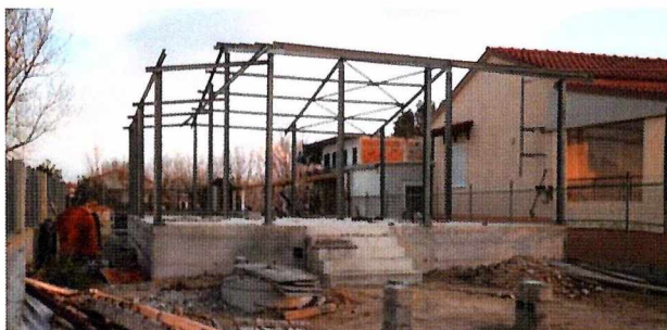
Εικόνα 82 Φέροντας Οργανισμός Αυθαίρετης Κατασκευής
