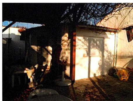
Όψη κτίσματος με επέκταση
