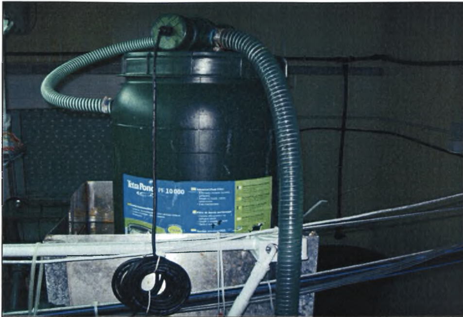
Εικόνα 5. Το μηχανικό, χημικό και βιολογικό φίλτρο.
