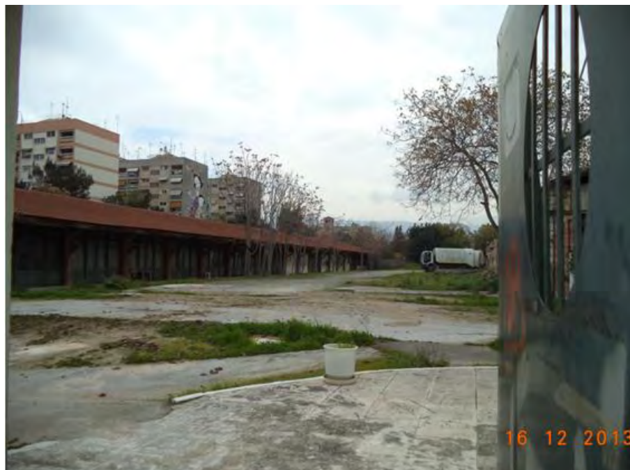
Εικόνα 40: Τα παλιά Σφαγεία στο δήμο Ταύρου στην οδό Πειραιώς & Επταλόφου
