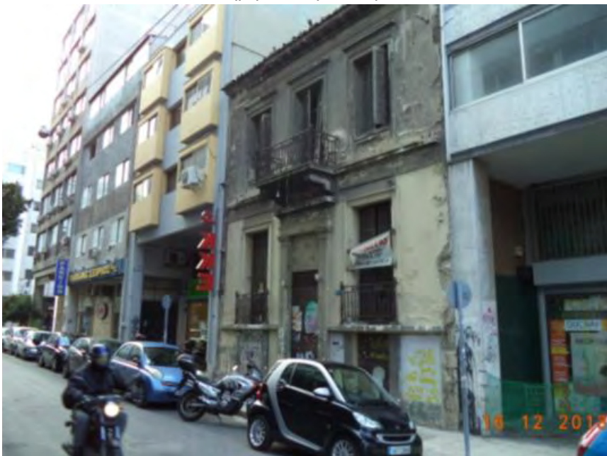
Εικόνα 20: Διατηρητέο κτίριο στην οδό Κολωνού 5
