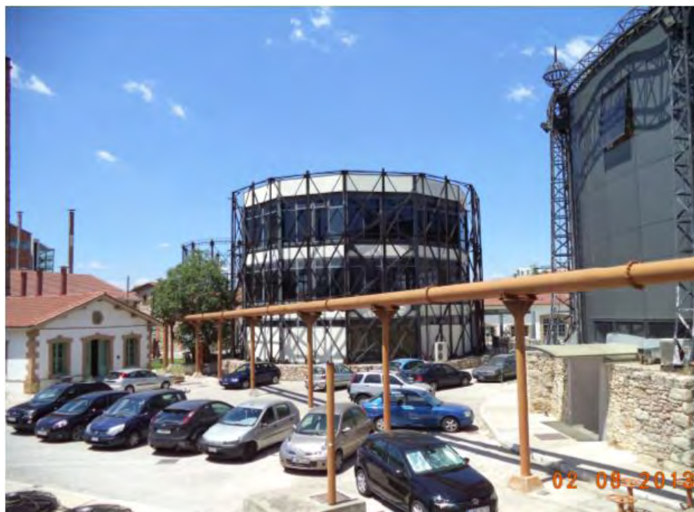
Εικόνα 31: Η Τεχνόπολη στο Γκάζι
