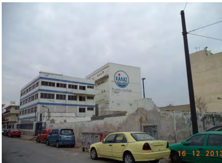
Εικόνα 45: Κτίριο βιομηχανίας “ΚΑΛΑΣ” στην οδό Πειραιώς 40
