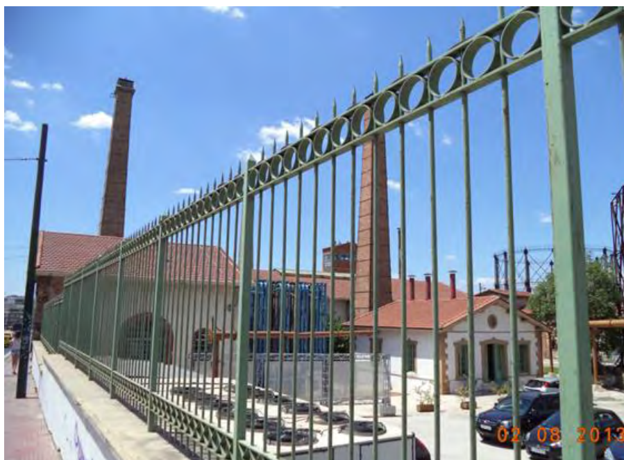
Εικόνα 32: Χαρακτηριστικές καμινάδες στη Τεχνόπολη, Γκάζι
