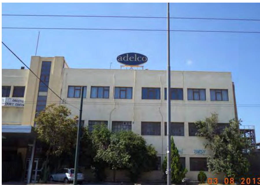
Εικόνα 48: Διατηρητέο κτίριο βιομηχανίας “Adelco” στην οδό Αθηνών-Πειραιώς 37
