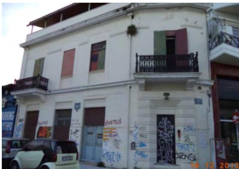
Εικόνα 22: Διατηρητέο κτίριο στην οδό Αγησιλάου 77
