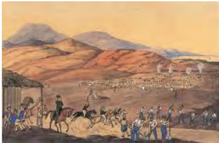
Εικόνα 10: Η κατασκευή της οδού Πειραιώς από βαυαρούς στρατιώτες
