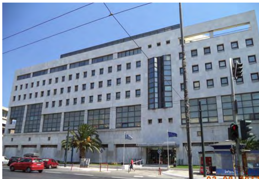
Εικόνα 34 : Υπουργείο Εσωτερικών στην οδό Πειραιώς 211
