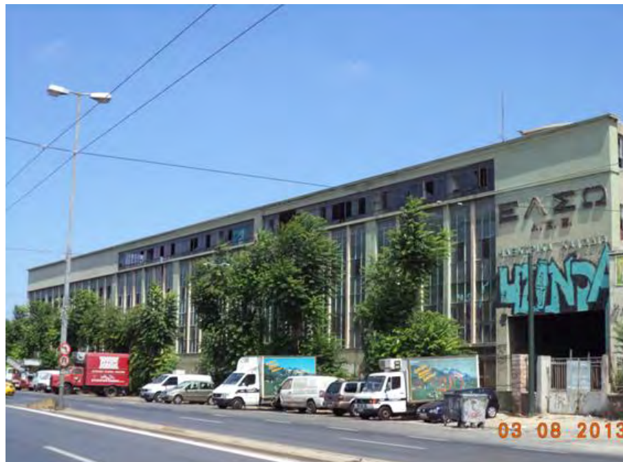
Εικόνα 38: Κτίριο βιομηχανίας “ΕΛ.ΣΩ” στην οδό Αθηνών-Πειραιώς 73
