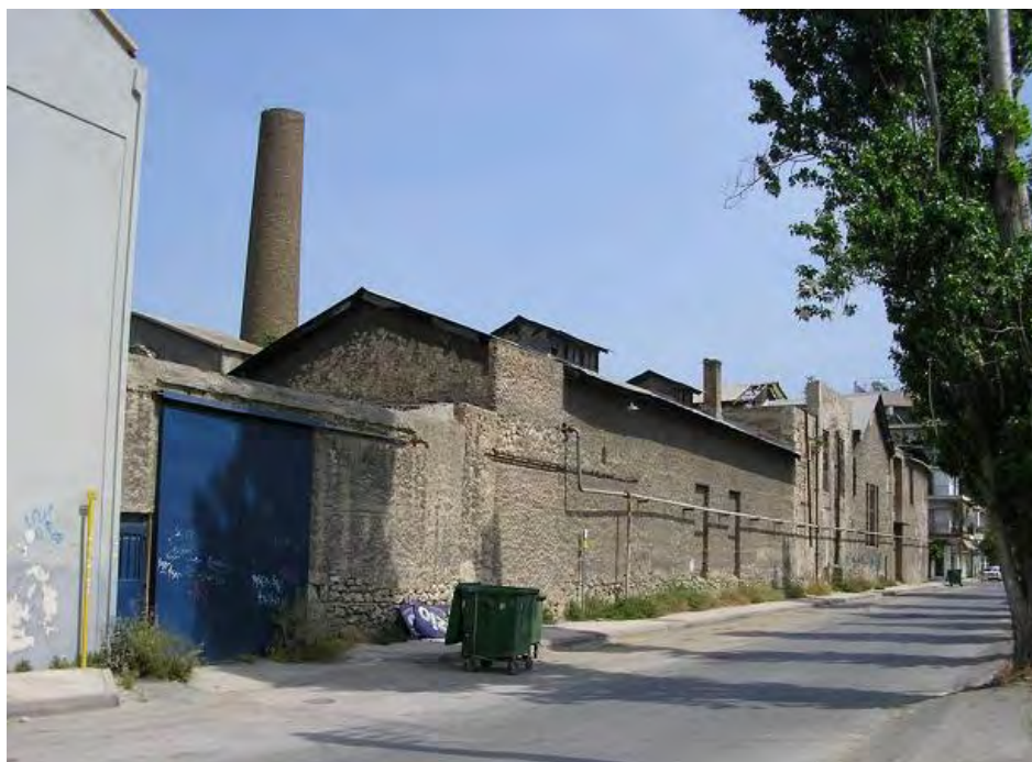
Εικόνα 50: Εγκαταλελειμμένο διατηρητέο κτίριο βιομηχανίας “ΧΡΩ.ΠΕΓ” στην οδό Αθηνών-Πειραιώς 68
