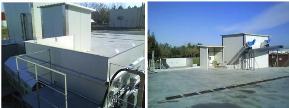
Εικόνα 4.3 – 4.4: Μονάδα επεξεργασίας λυμάτων αποφρακτικών στη ΜΕΥΑ Λάρισας.
