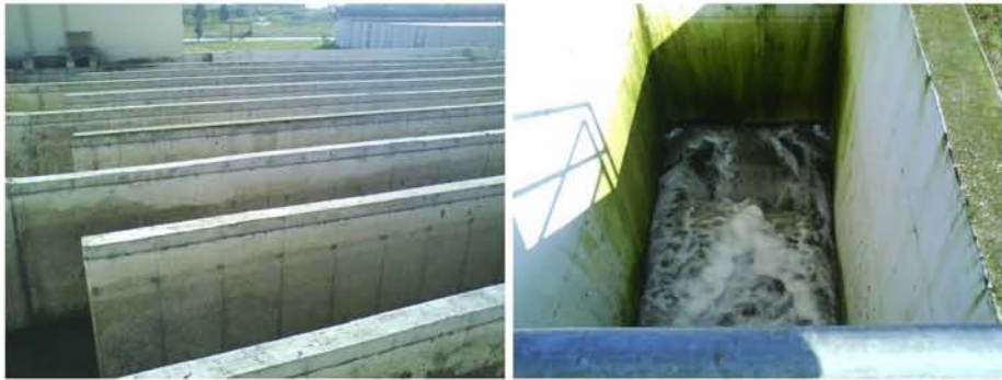
Εικόνα 4.14 – 4.15: Χλωρίωση και φρεάτιο εξόδου επεξεργασμένου νερού.
