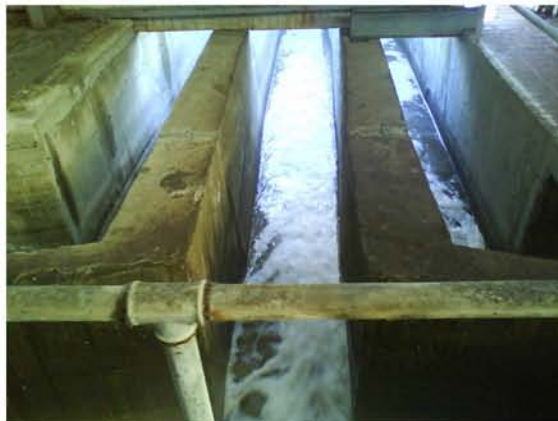
Εικόνα 4-8: Κανάλι τύπου Venturi για την μέτρηση παροχής στην ΕΕΛ Λάρισας.
