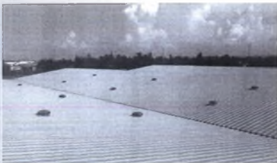
Αποθηκευτικός χώρος στα Οινόφυτα
