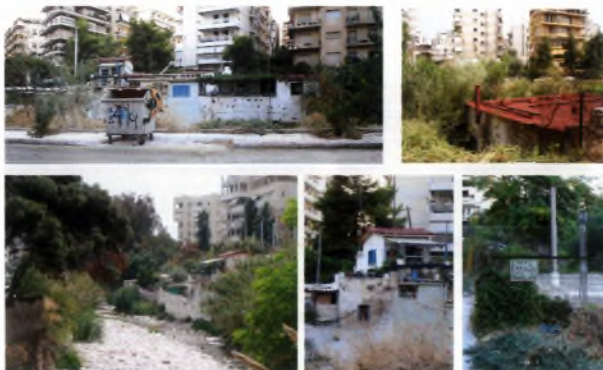
Εικ.3. 46 αυθαίρετα κτίσματα
